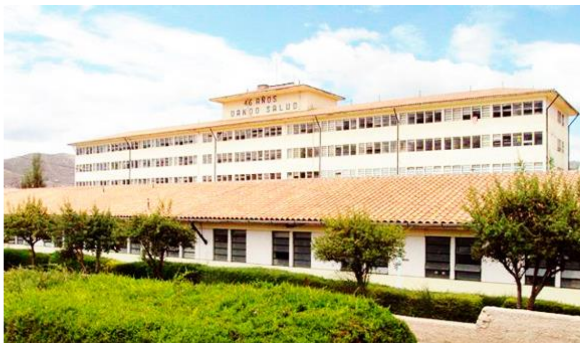
Figura N° 1. HOSPITAL REGIONAL DEL CUSCO
