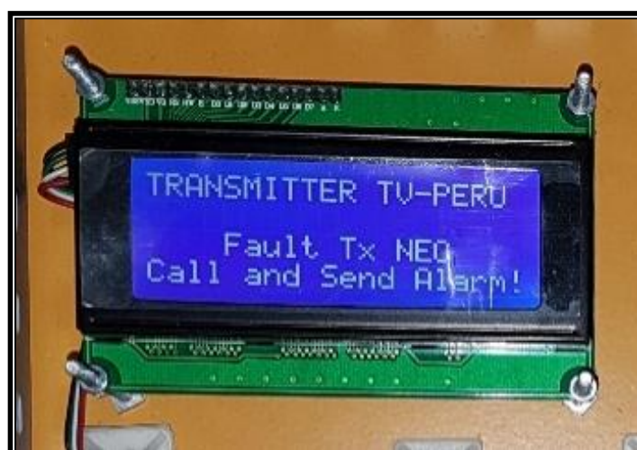
Alarma Falla Energía
