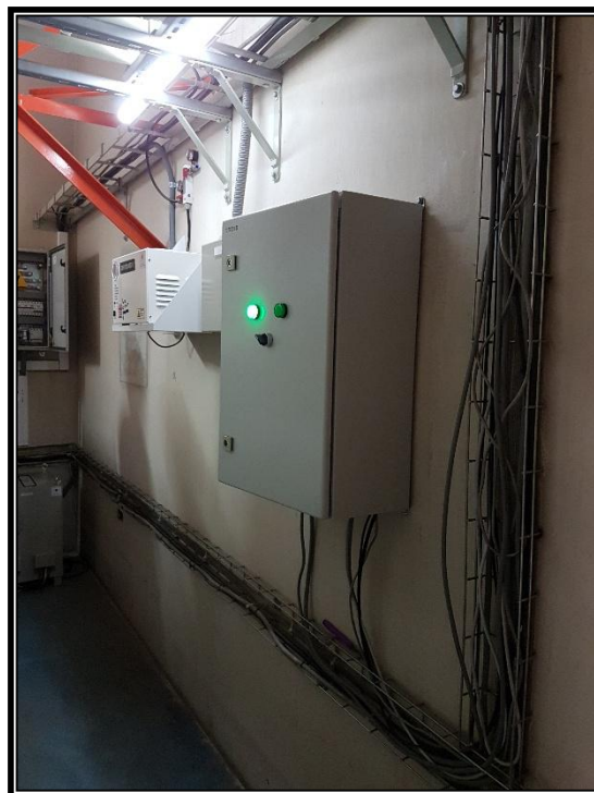
DESPUES DE INSTALACION
