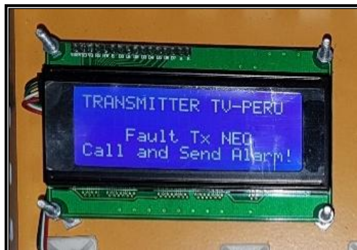
Alarma Falla en TX Control
