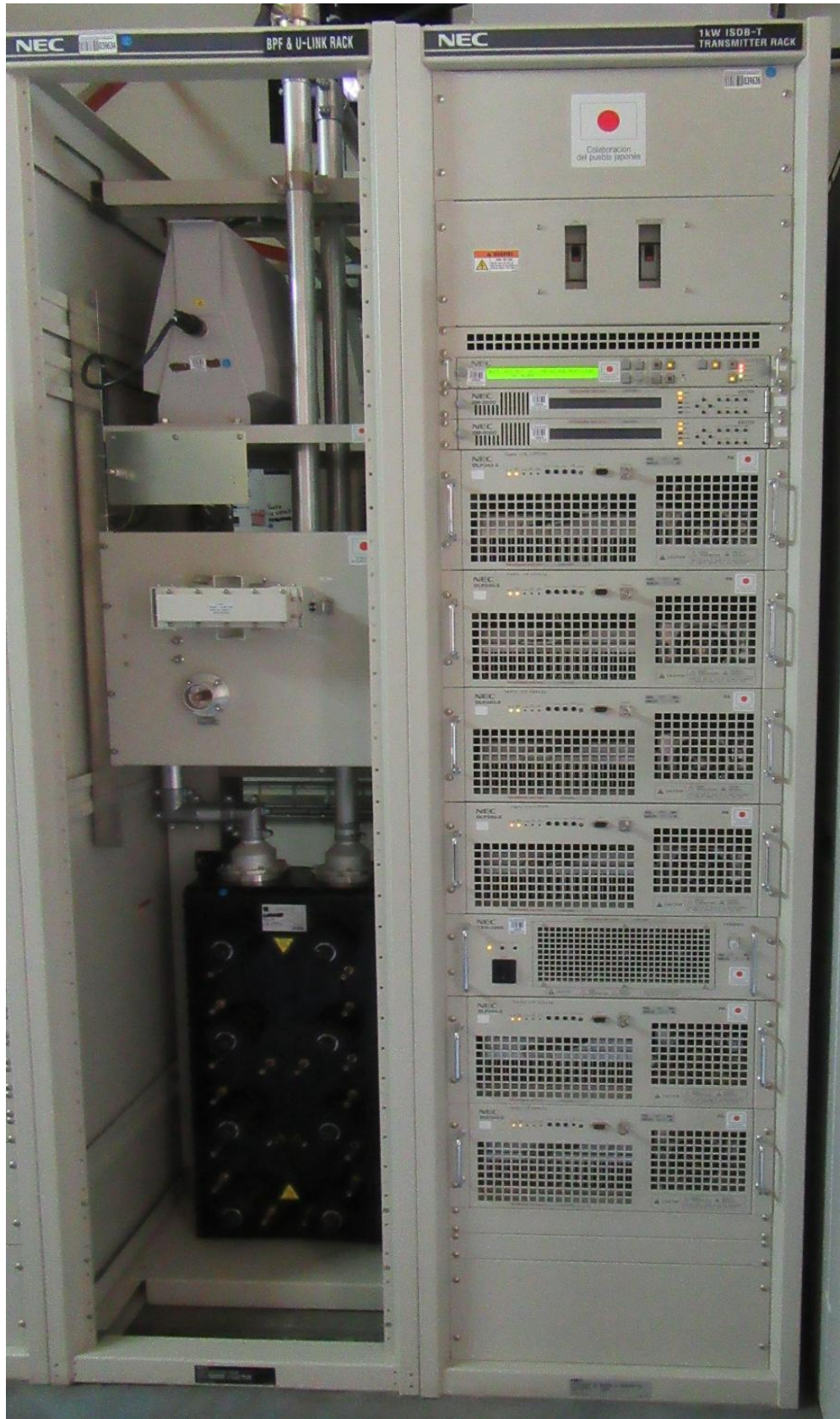
Figura 15. Sistema de transmisión digital EWBS
