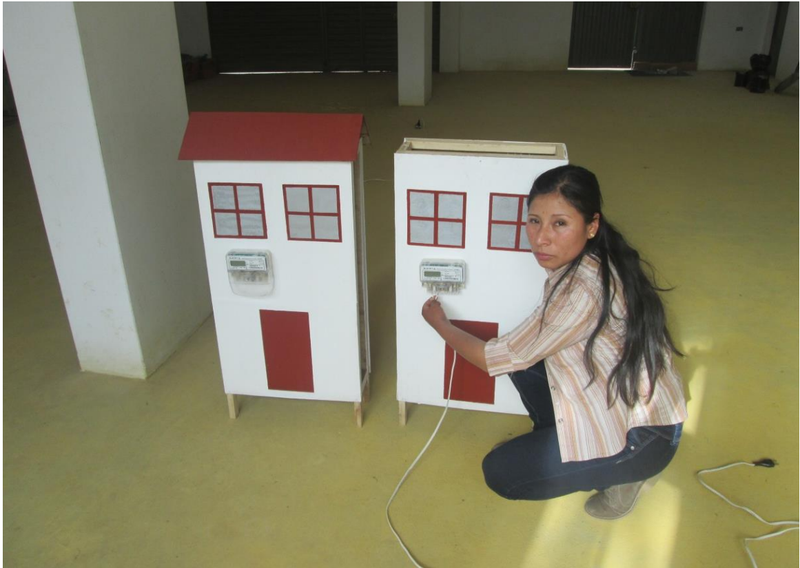
Foto 3 Instalación de los medidores electrónicos por la investigadora
