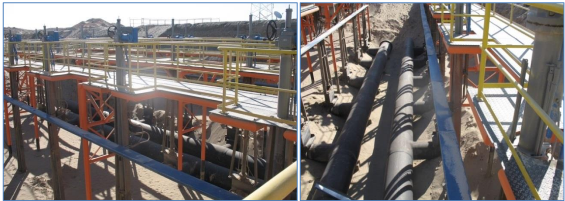
Figura N° 2312: Patio de válvulas, vista frontal e inferior.
