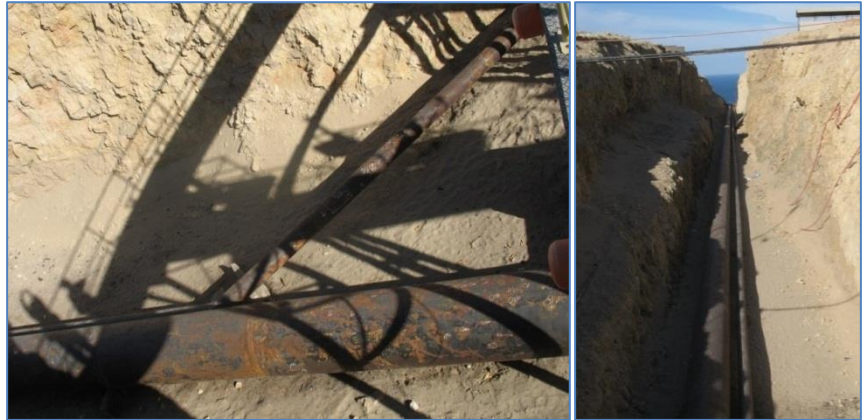
Figura N° 13: Tuberías de descarga y retorno.
