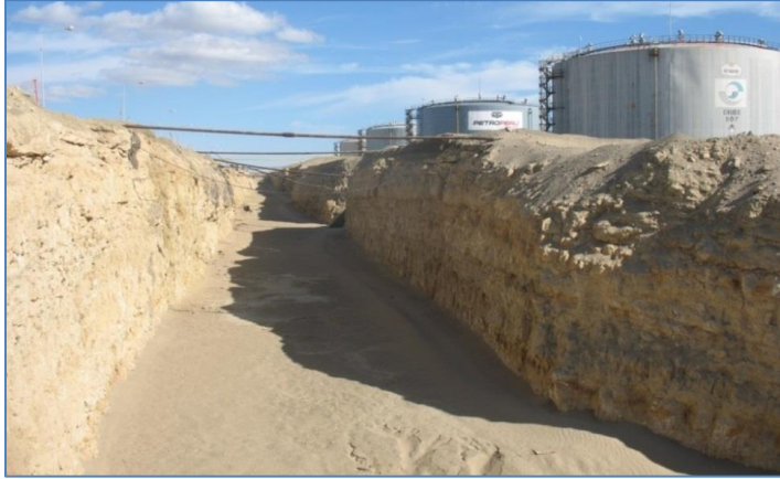
Figura N° 10: Sendero principal, luego de cubiertas las tuberías con 1m de arena.
