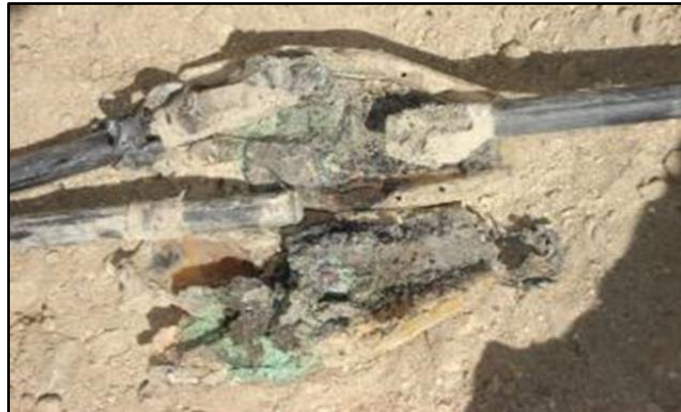
Figura N° 6: Falla del aislamiento del empalme
