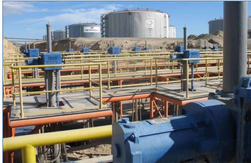
Figura N°22: Patio de válvulas, vista superior.
