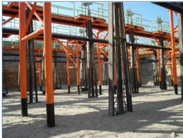
Figura N° 11: Zona de patio de válvulas
