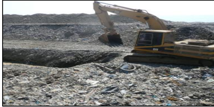
Figura N°7: Excavación ampliación vía de tuberías
