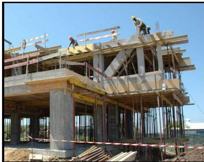
Imagen N°01: Ejecución de obra
