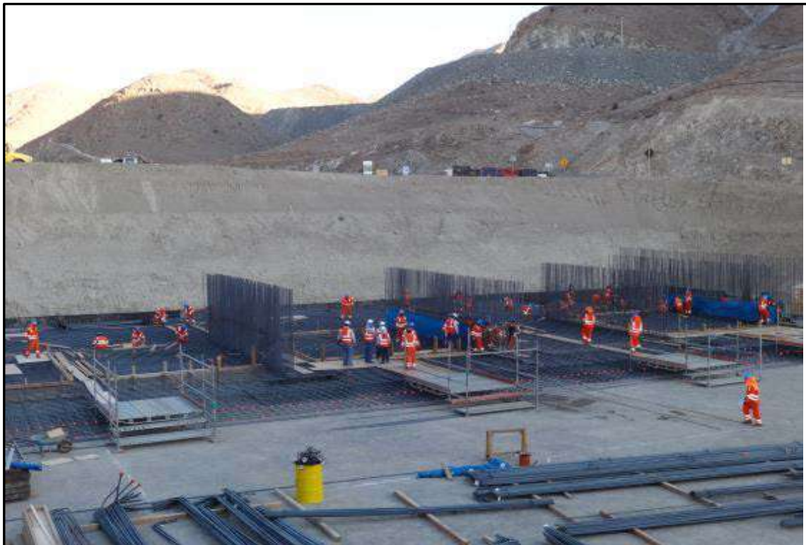
Foto 3.6. Armado de acero para losas
