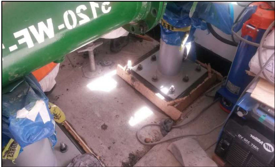
Foto 3.11. Encofrado de grout para soportes de tubería
