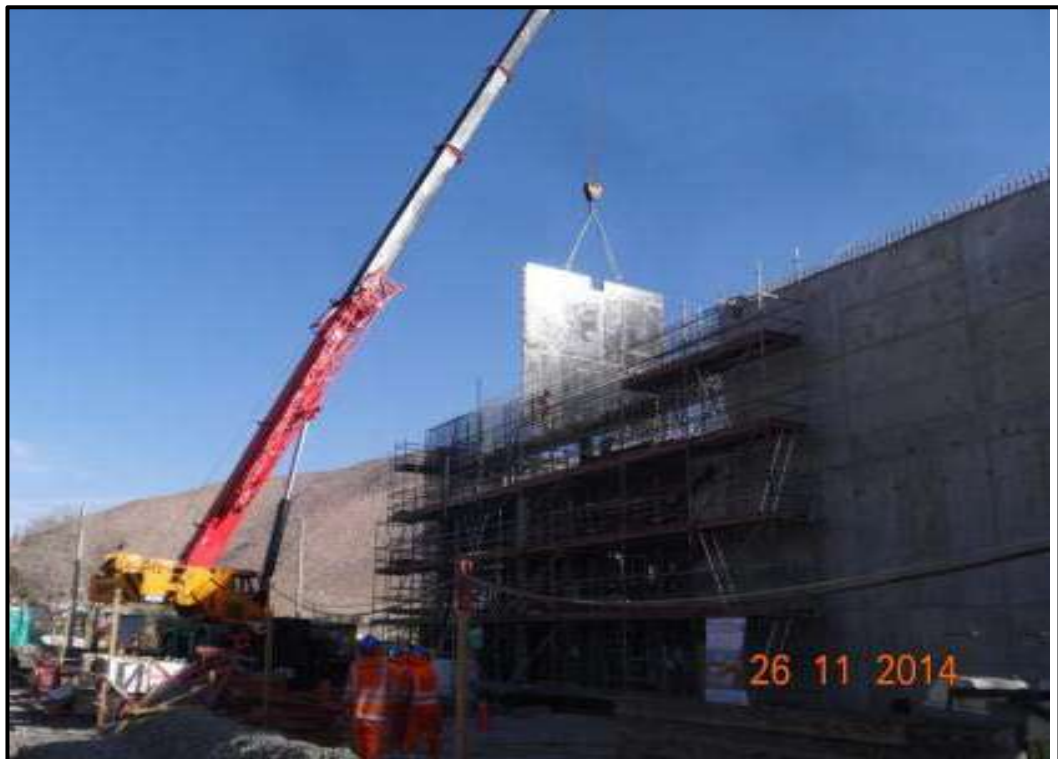
Foto 3.9. Alineación de panel de encofrado en muros del TCS
