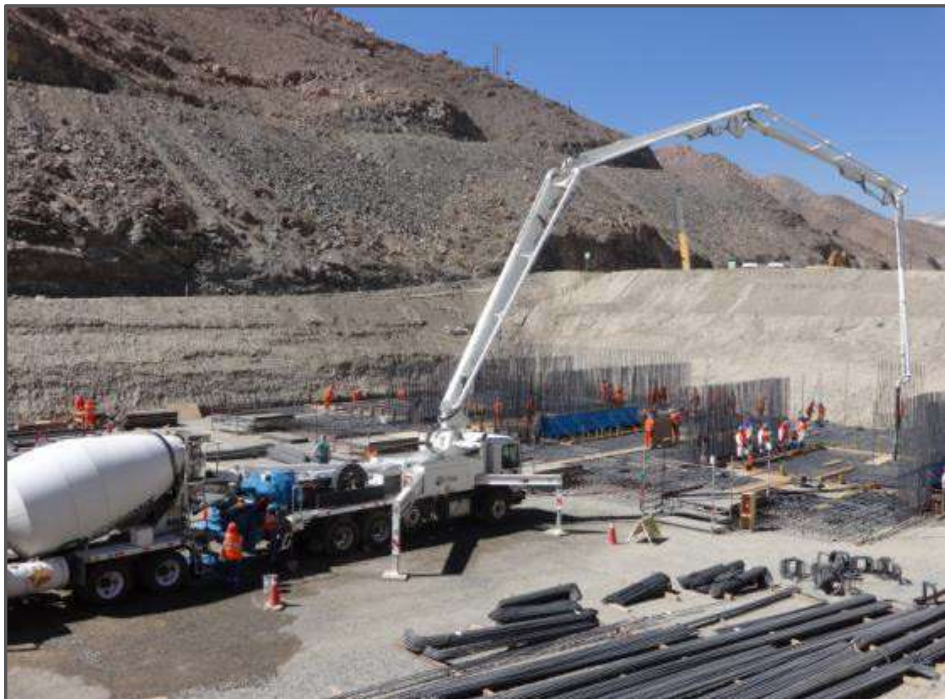
Foto 3.5. Preparación de Bomba para Vaciado
