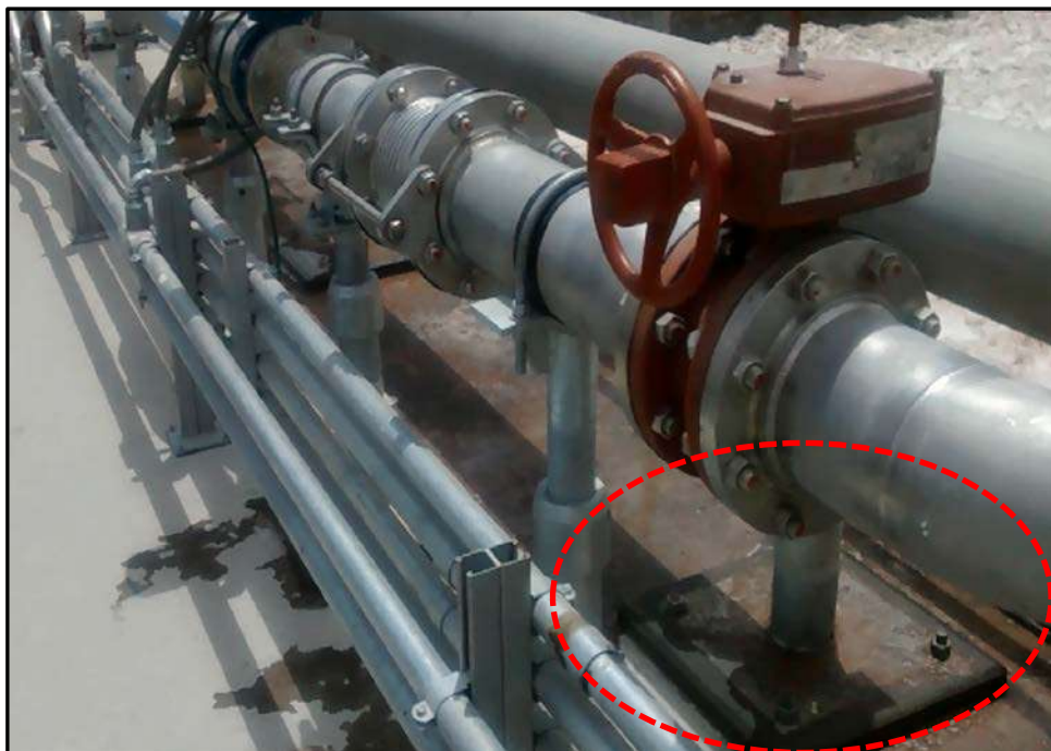
Foto 3.13. Base de Grout para el Soporte de Tubería Tipo M-108(Figura 3.14).
