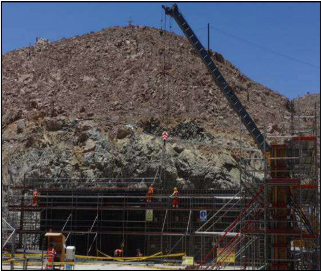
Foto 3.10. Desencofrado en muros del TCS
