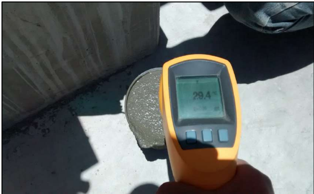
Foto 3.12. Medición de la temperatura de la mezcla de grout con pirómetro
