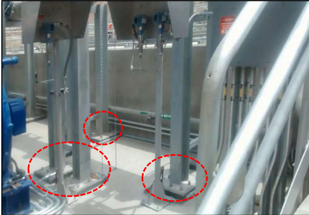
Foto 3.14. Base de Grout para el Soporte de Tubería Tipo M-906 (Figura 3.14).
