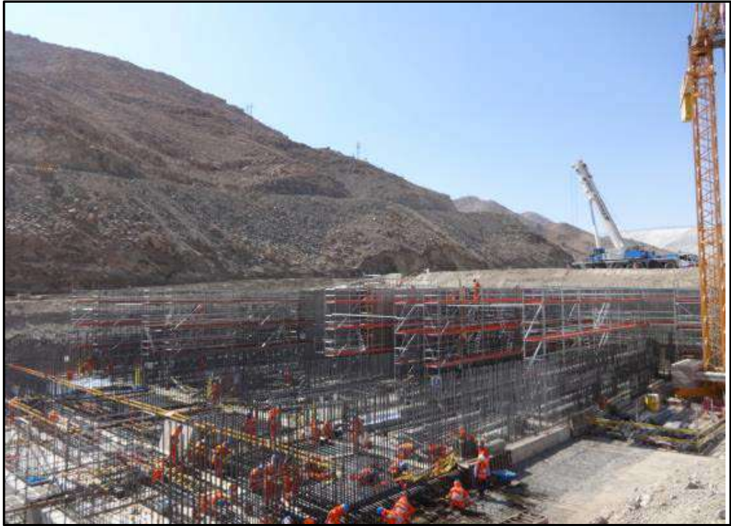
Foto 3.7. Armado de acero para muros
