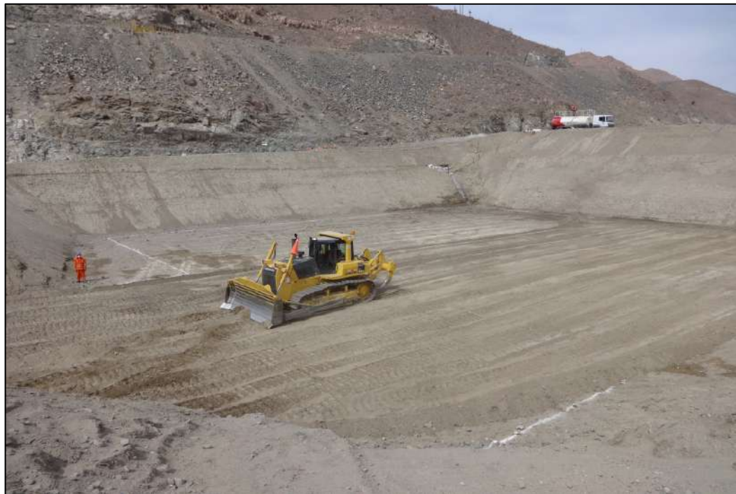
Foto 3.2. Corte y nivelación de terreno
