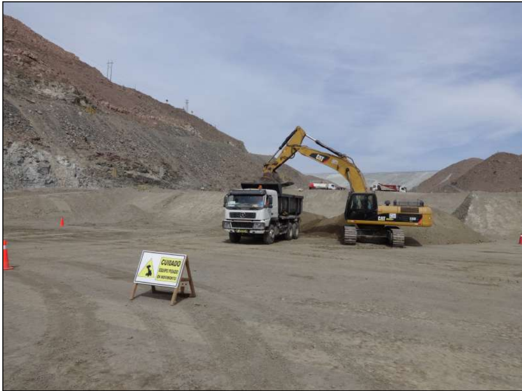
Foto 3.3. Transporte de material de relleno estructural
