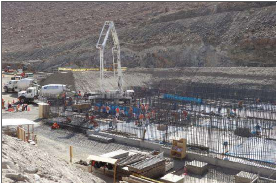
Foto 3.4. Vaciado de losas del Tanque de Contacto de Sólidos
