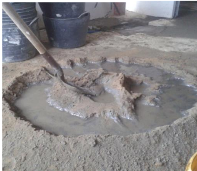
Ilustración 17: Realización de mortero o mezcla
