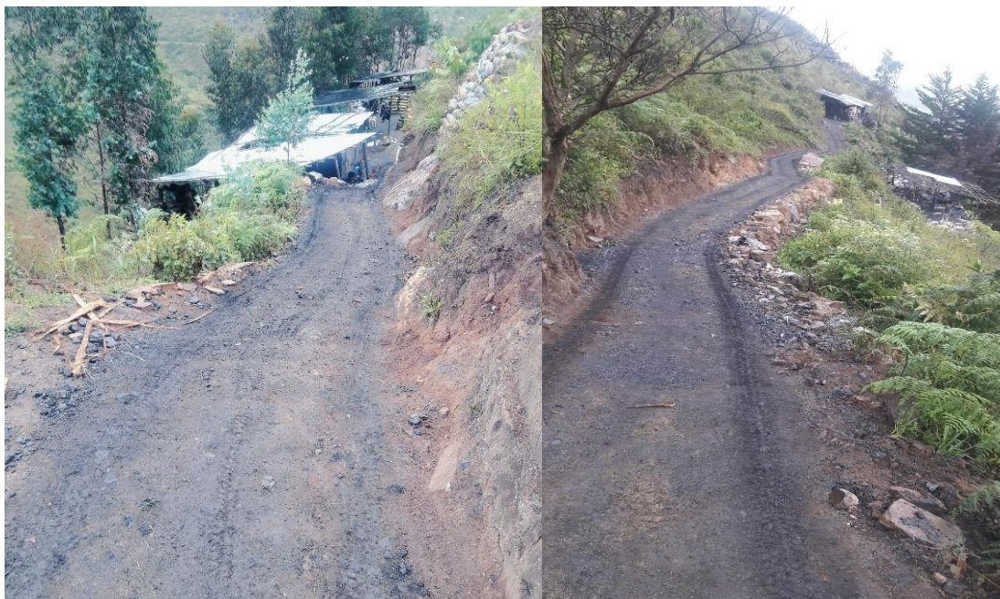
Figura 64. Acceso a las labores mineras Mi Grimaldina 1 Fuente: Elaboración propia, 2017.
