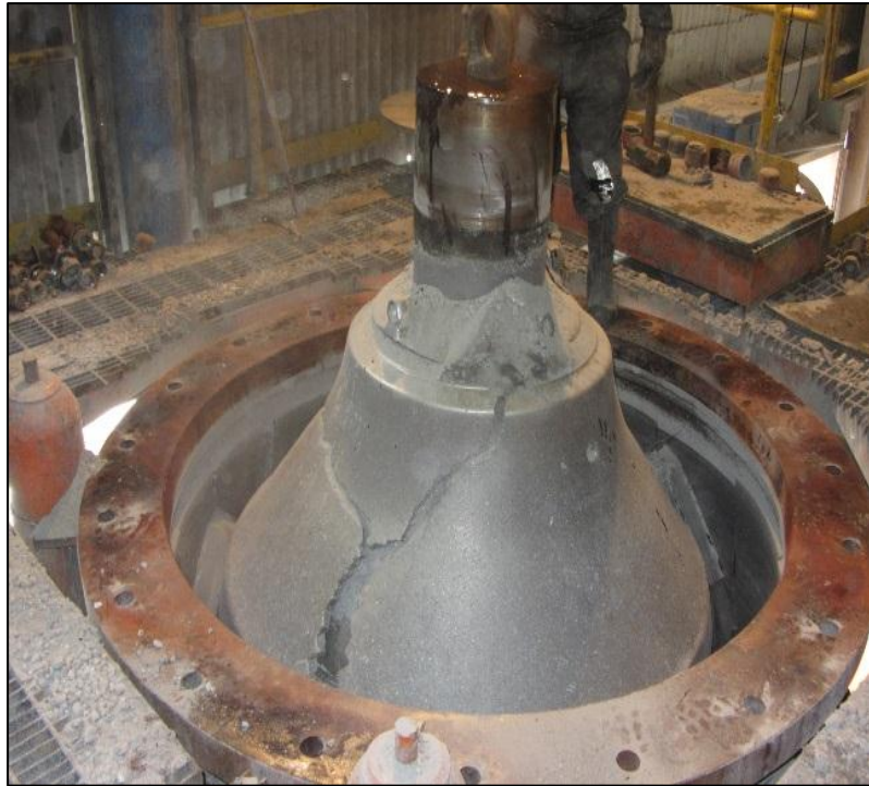
Figura 2. Rotura de forros mantle
