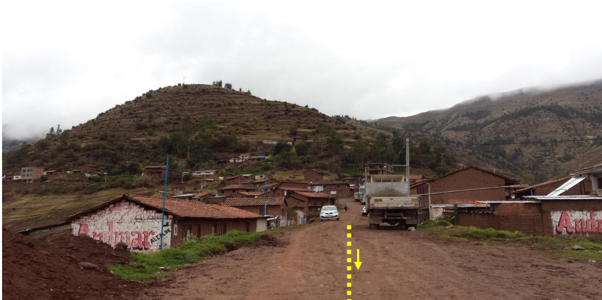
Foto N° 01: Colector calle principal
