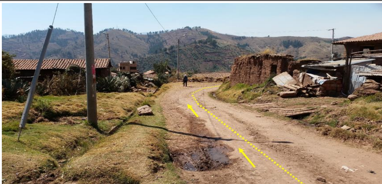
Foto N° 01: Colector calle lateral entre los buzones de inspección
