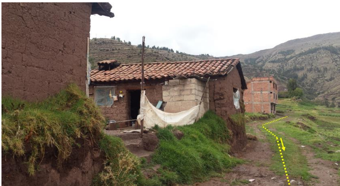
Foto N° 02: Colector calle lateral entre los buzones de inspección
