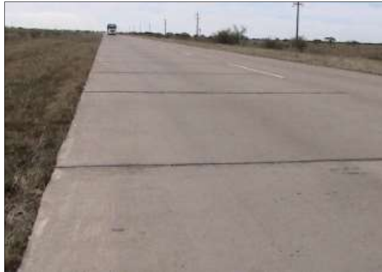
Imagen N° 19 Bombeo de Juntas
