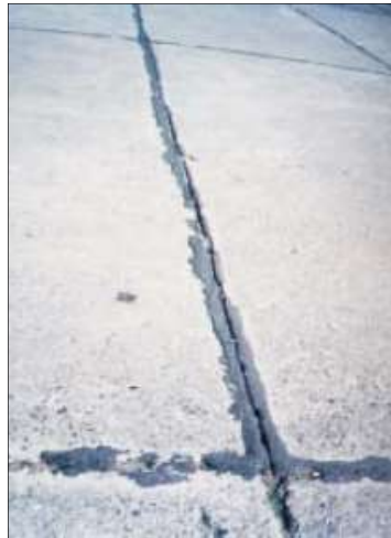
Imagen N° 09 Deficiencias de Sellado
