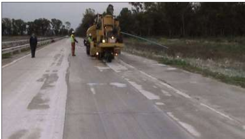
Imagen N° 21 Pulido del pavimento
