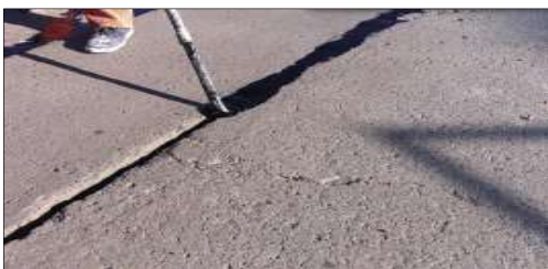
Imagen N°18 Sellado de Junta de Dilatación
