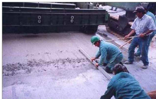
Imagen N° 04 Juntas de Construcción
