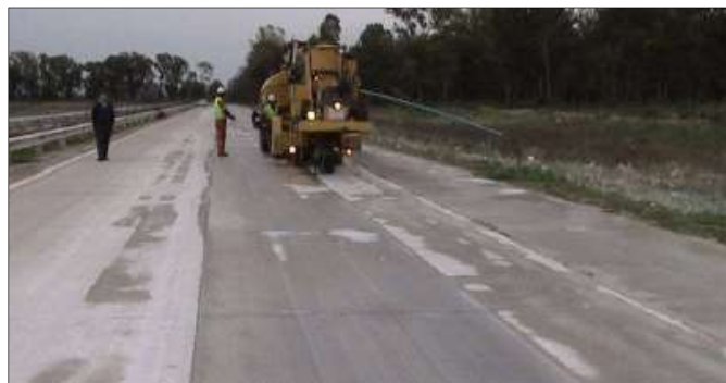
Imagen N° 21 Pulido del pavimento
