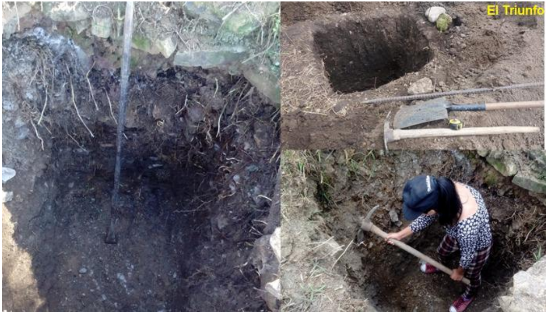
Figura 35: Elaboración de calicata. Fuente: Elaboración propia, 2017.
