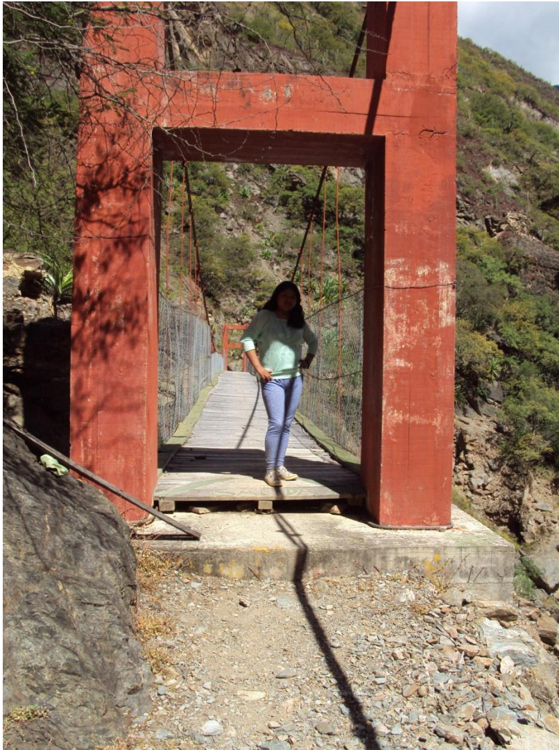
Figura N° 12 Puente San Francisco.
