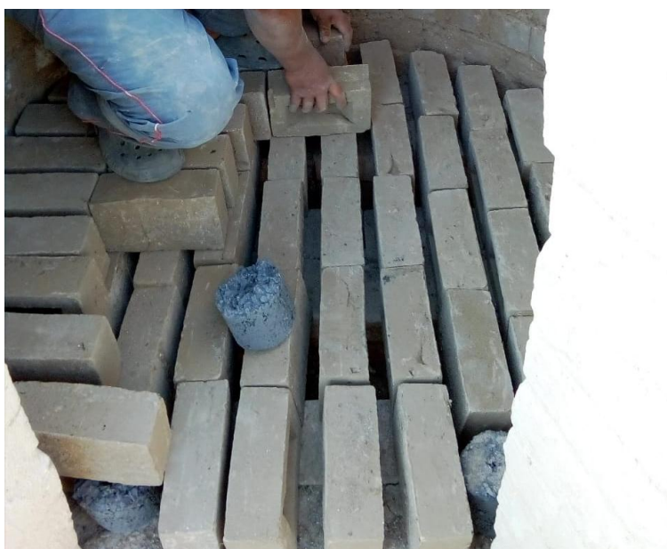
Figura 55. Vista de posición del ladrillo crudo en el horno.
