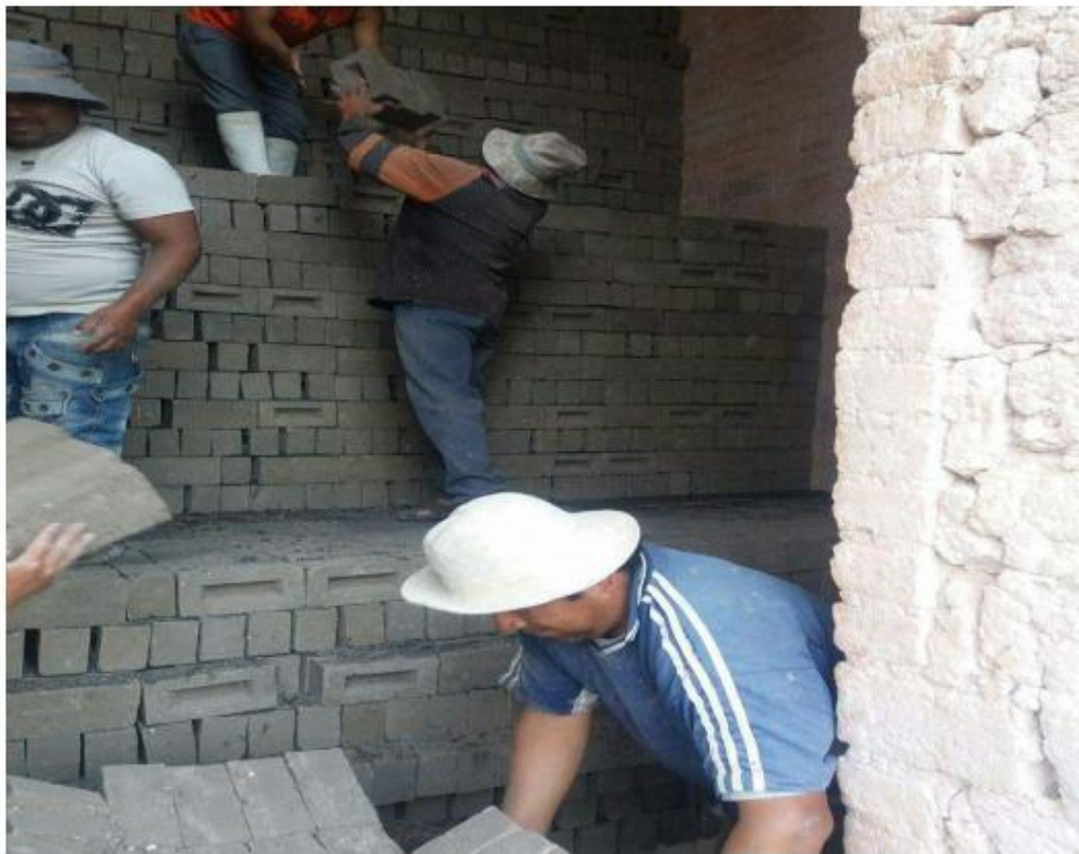
Figura 12. Apilado del ladrillo en el horno para su cocción.
