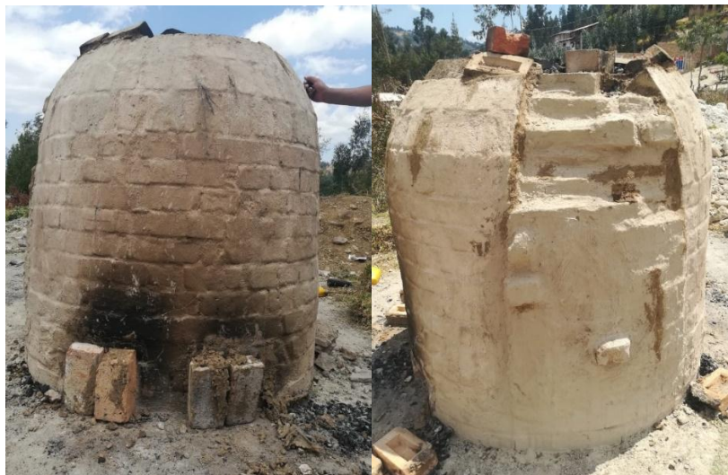
Figura 67. Clausura de los conductos de carga de ladrillo y de ingreso de leña. Fuente: Elaboración Propia, 2018.
