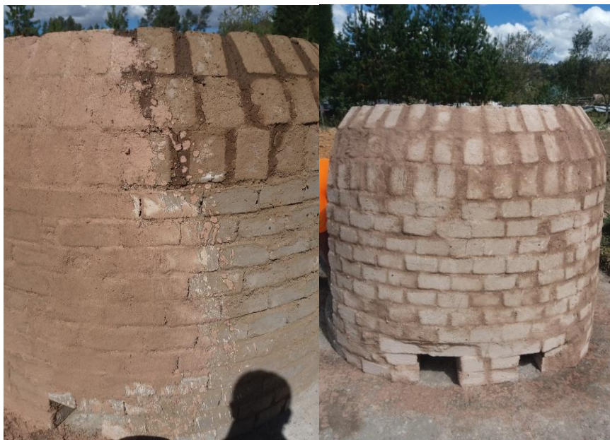
Figura 49. Vista preliminar del revestimiento del horno. Fuente: Elaboración Propia, 2018.
