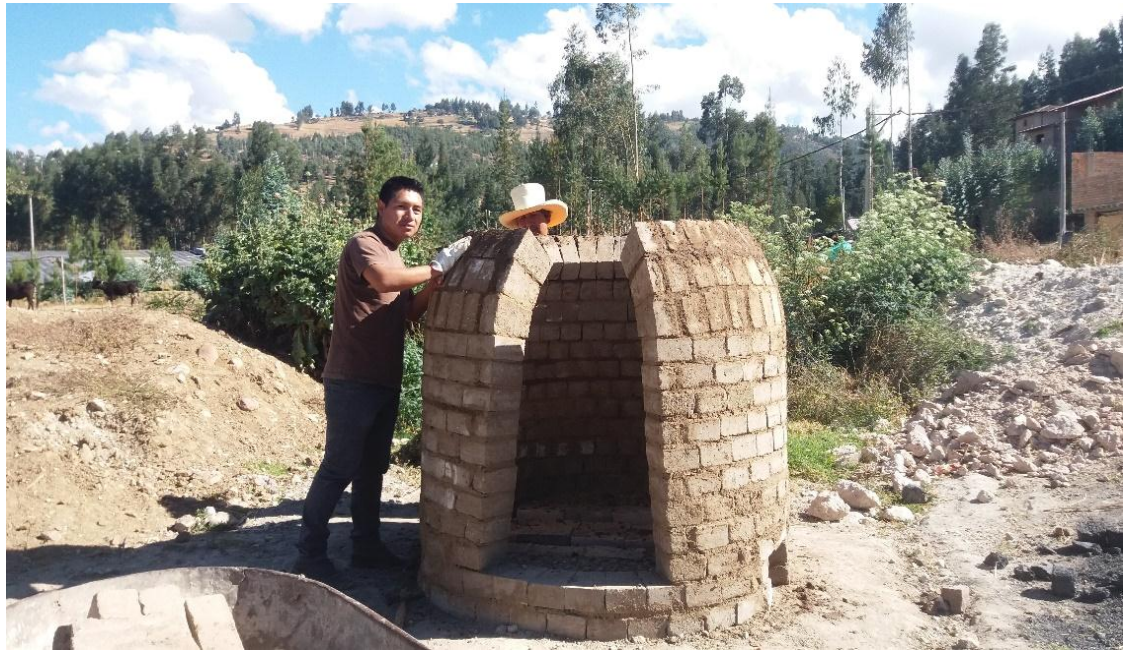
Figura 64. Horno construido en su totalidad.
