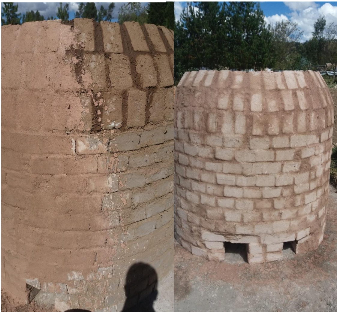
Figura 65. Arenado del horno o capa impermeabilizante.
