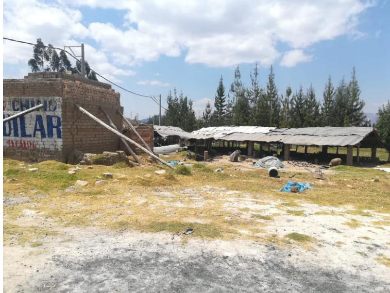
Figura 62. Limpieza del área de construcción del horno.
