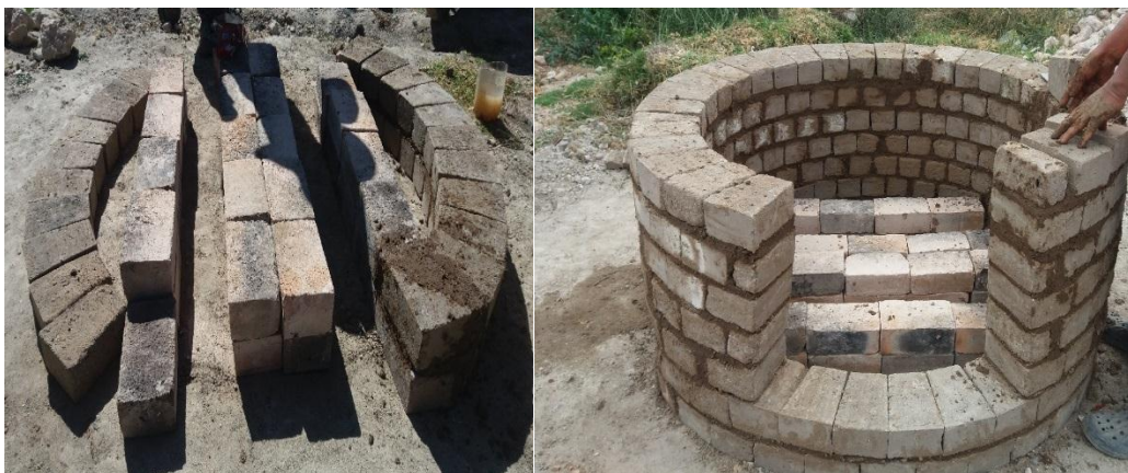
Figura 63. Trazo de bases del horno y conductos de ingreso de leña.
