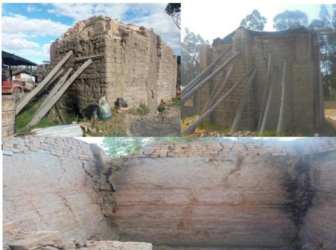
Figura 1. Estado actual de los hornos
