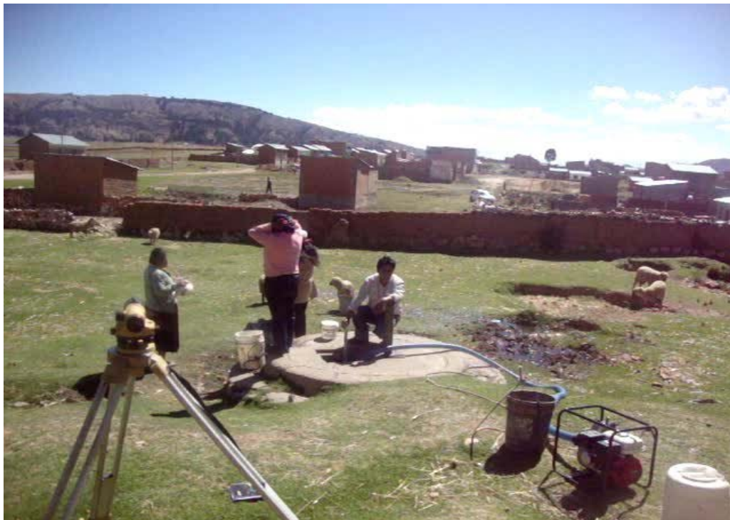
Figura 5-1, Mediando la profundidad del pozo construido y el espejo de agua.
