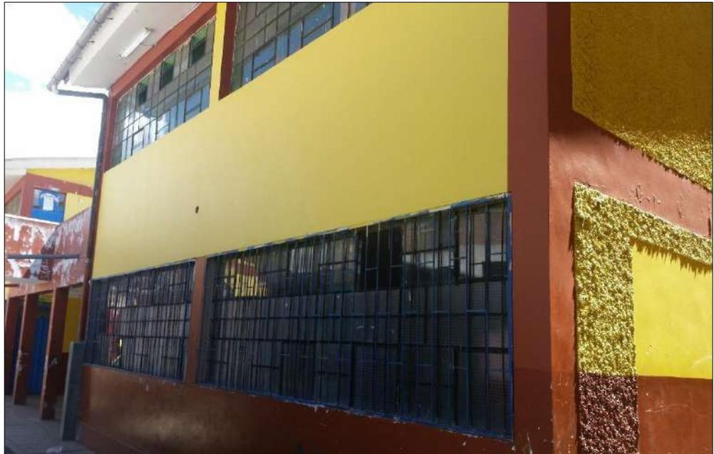
**Fotografía N° 10: Pabellón Oscar Colchado Lucio** (El sistema resistente presenta mampostería en ladrillo de buena calidad, presencia de verticalidad entre las unidades de albañilería).
