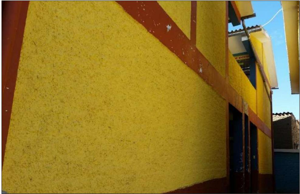
**Fotografía N° 11: Pabellón Marcos Yauri Montero** (El sistema resistente presenta mampostería en ladrillo de buena calidad, presencia de verticalidad entre las unidades de albañilería).
