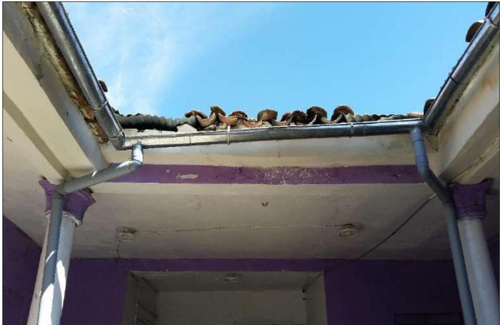
**Fotografía N° 36: Administrativo** (Edificio con cubierta inestable, provista de viga cumbre).
