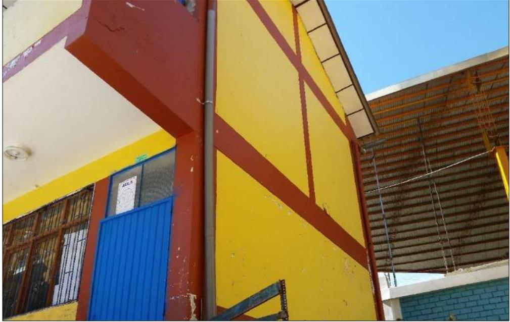
**Fotografía N° 09: Pabellón Ladislao Meza Landaveri** (El sistema resistente presenta mampostería en ladrillo de buena calidad, presencia de verticalidad entre las unidades de albañilería).
