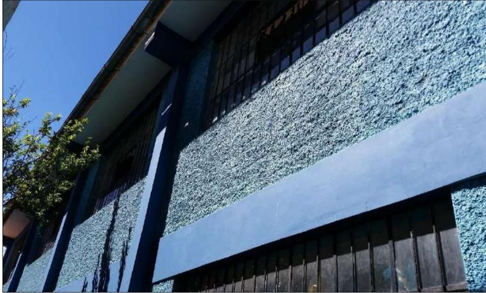
**Fotografía N° 05: Pabellón Marcos Yauri Montero** (Edificio que presenta en todos los pisos, vigas y columnas de amarre).
