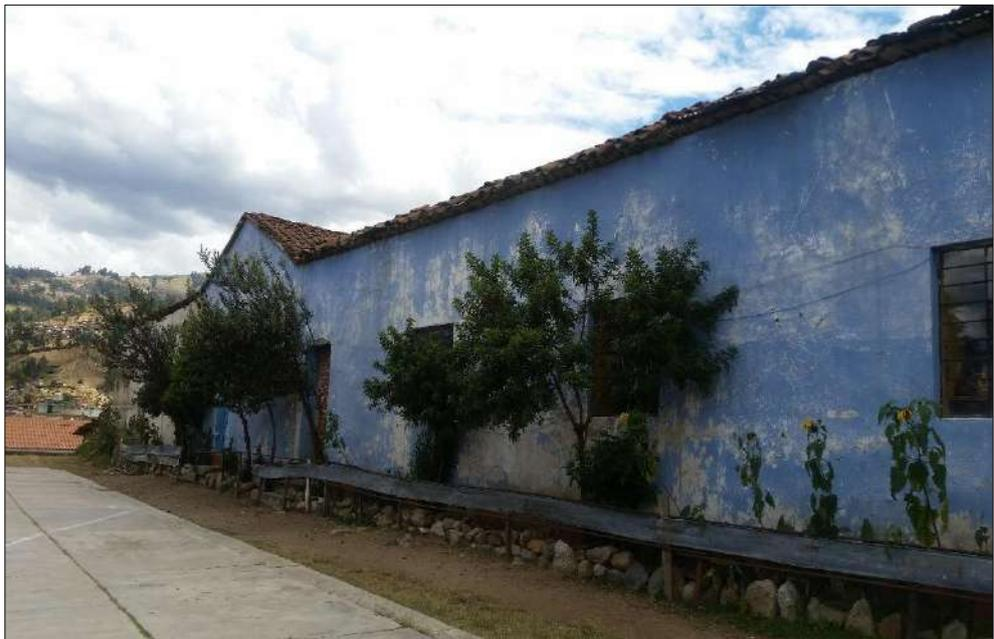
**Fotografía N° 18: Pabellón Administrativo** (Edificio cimentado sobre terreno estable con pendiente inferior o igual al 10%).
