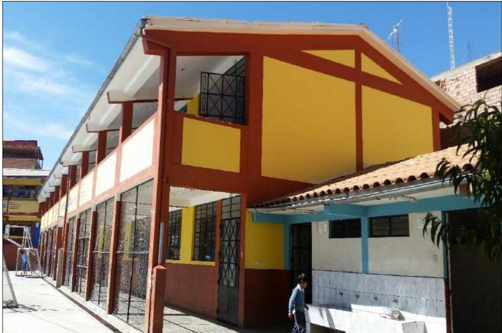
**Fotografía N° 08: Pabellón María Dictenia Alvarado Trujillo** (El sistema resistente presenta mampostería en ladrillo de buena calidad, presencia de verticalidad entre las unidades de albañilería).
