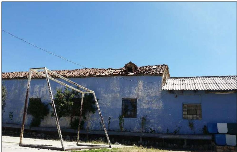
**Fotografía N° 42: Administrativo** (Edificio que presenta chimeneas o cualquier otro tipo en el techo, mal vinculados a la estructura).
