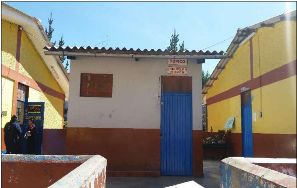
**Fotografía N° 40: Oscar Colchado Lucio** (Edificio con elementos de pequeña dimensión, mal vinculados a la pared).
