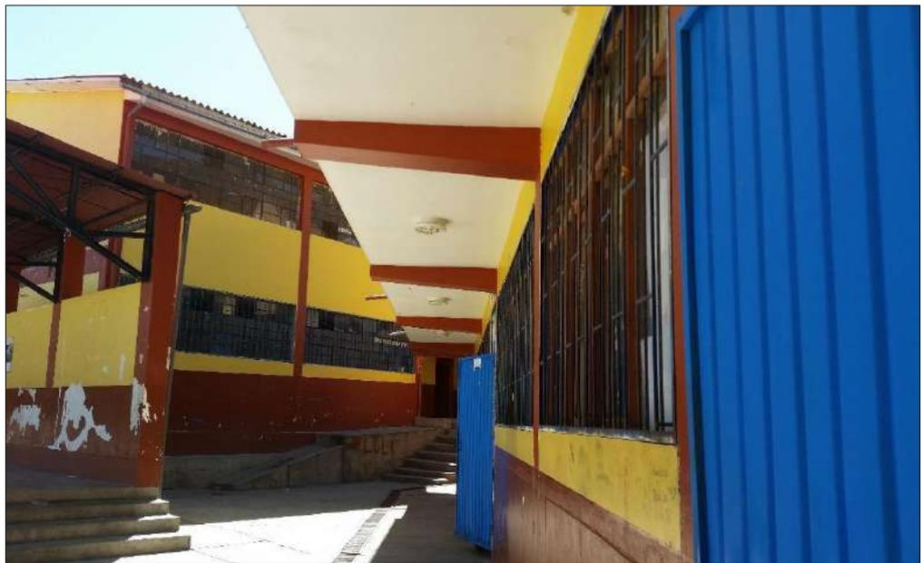
**Fotografía N° 22: Pabellón Oscar Colchado Lucio** (Edificio con diafragmas que cumplan las siguientes condiciones: ausencia de planos a desnivel, deformabilidad del diafragma despreciable, conexión entre el diafragma y los muros es eficaz).
