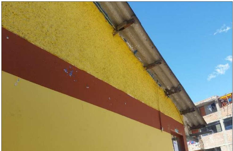
**Fotografía N° 34: Oscar Colchado Lucio** (Edificio con cubierta inestable, provista de viga cumbre).
