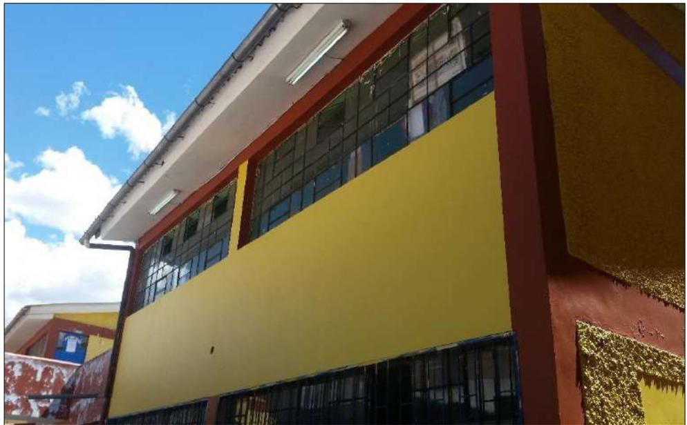
**Fotografía N° 46: Oscar Colchado Lucio** (Edificio con muros en buena condición, sin lesiones visibles).
