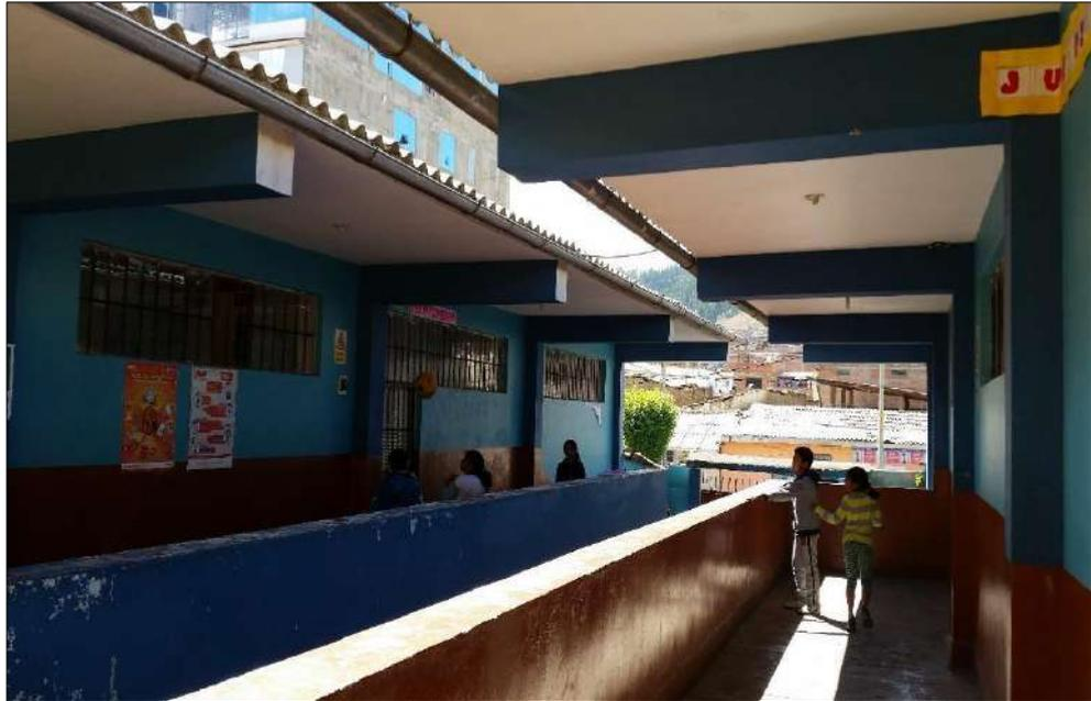
**Fotografía N° 41: Marcos Yauri Montero** (Edificio cuyo pasadizo forma parte integrante de la estructura de los diafragmas).
