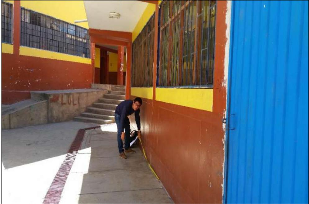
**Fotografía N° 45: Ladislao Meza Landaveri** (Muros con lesiones de tamaño medio entre 2 a 3 mm de ancho o con lesiones capilares producidas por los sismos).
