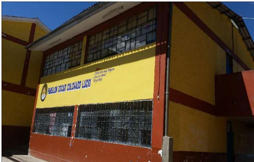
**Fotografía N° 04: Pabellón Oscar Colchado Lucio** (Edificio que presenta en todos los pisos, vigas y columnas de amarre).
