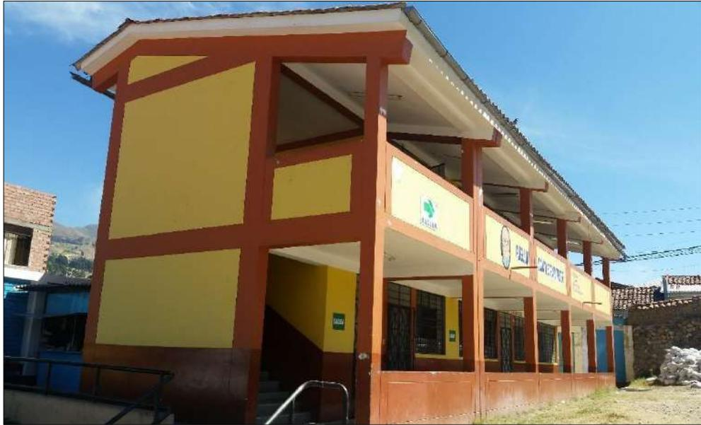
**Fotografía N° 19: Pabellón Augusto Soriano Infante** (Edificio con diafragmas que cumplan las siguientes condiciones: ausencia de planos a desnivel, deformabilidad del diafragma despreciable, conexión entre el diafragma y los muros es eficaz).
