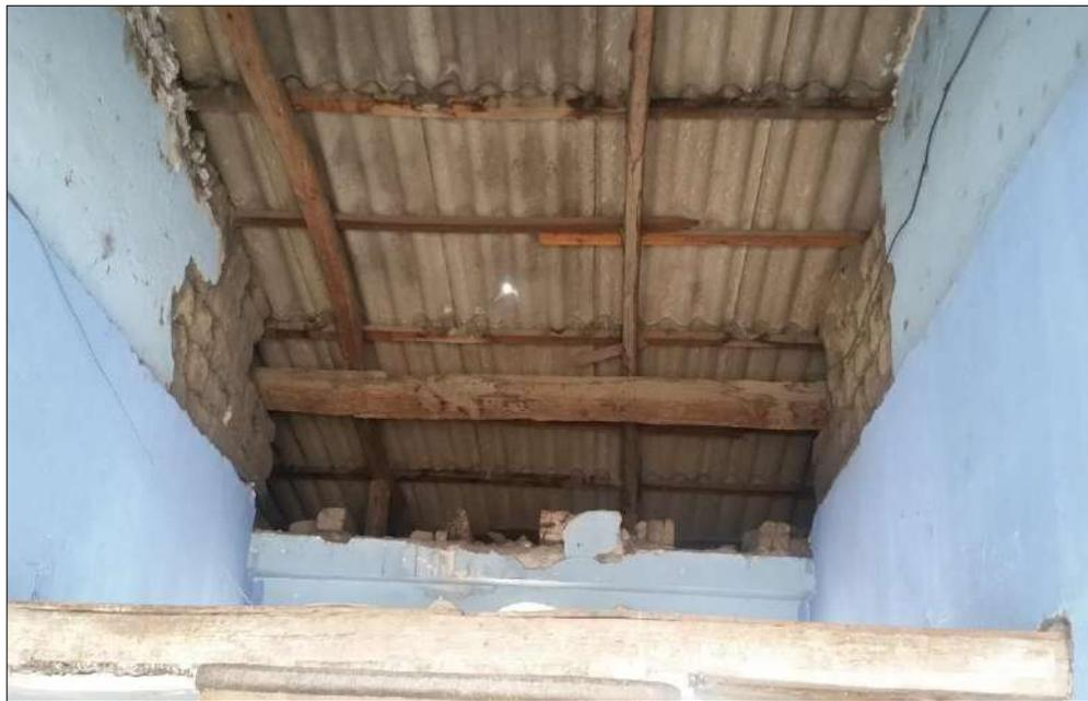
**Fotografía N° 12: Pabellón Administrativo** (El sistema resistente presenta mampostería en adobe de mala calidad, no presenta verticalidad entre las unidades de albañilería y mortero de mala calidad).
