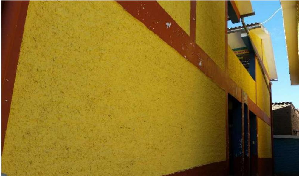
**Fotografía N° 47: Marcos Yauri Montero** (Muros que presentan lesiones capilares no extendidas).
