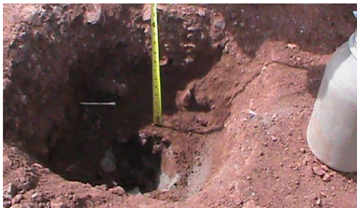
Figura N° 16: Profundidad de Compactación
