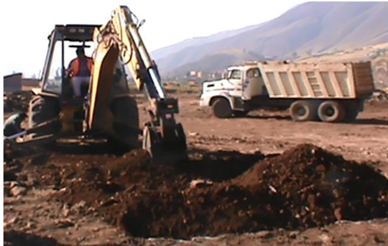
Figura N° 13: Tendido y Escarificación del Material de préstamo
