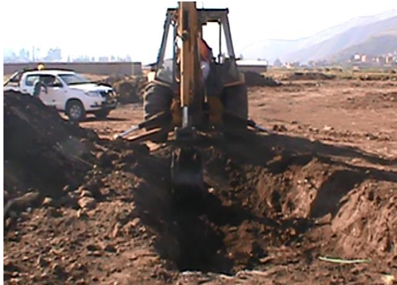
Figura N° 11: Escarificación de Terreno
