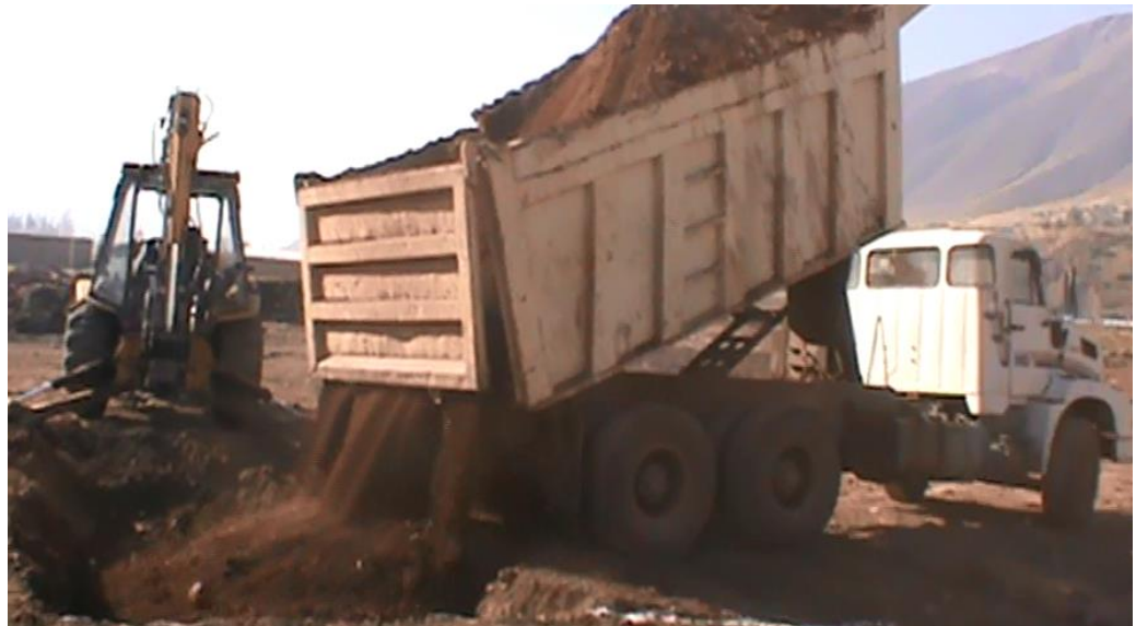
Figura N° 12: Tendido del Material
