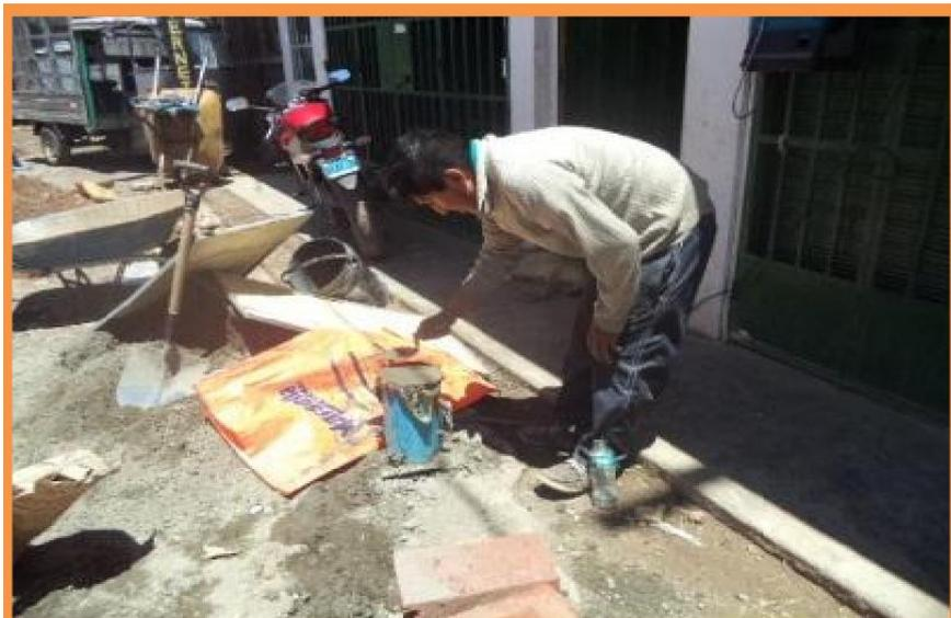
Probetas de concreto  $f_c=175 \text{ kg/cm}^2$ . en losa de caja de entrada y salida
