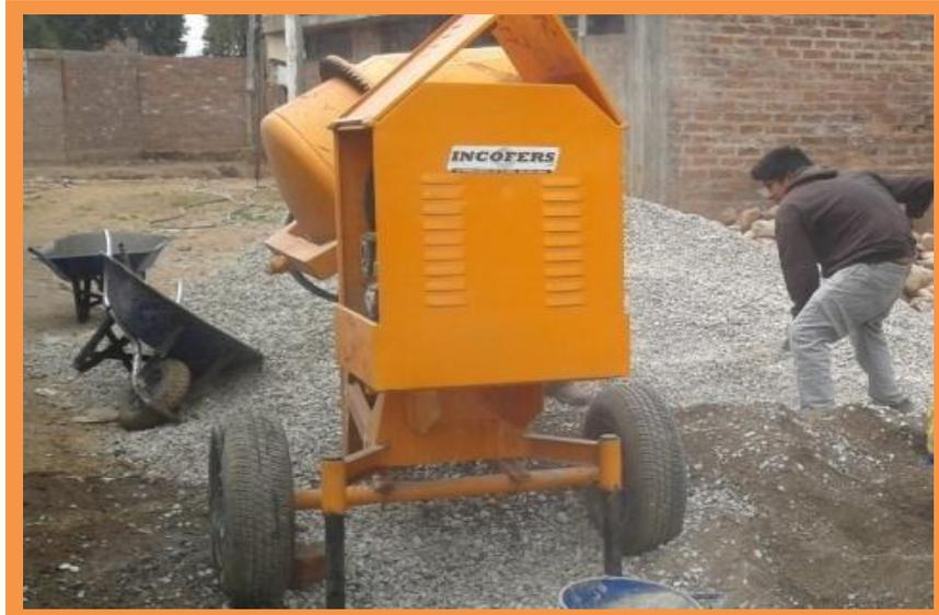
Mezcladora de concreto 9 p3 para Concreto  $f_c=210 \text{ kg/cm}^2$
