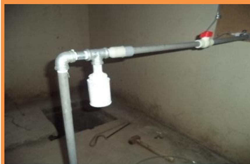
Botella de trampa para agua (válvula de seguridad de Biogás)
