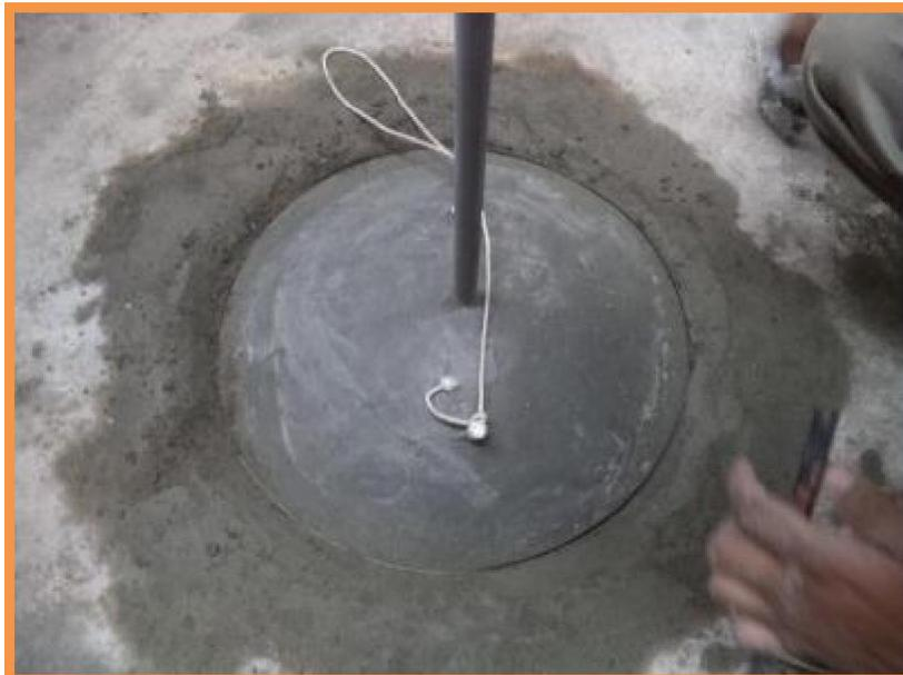
Sellado de la tapa para evitar posibles fugas de Biogás.
