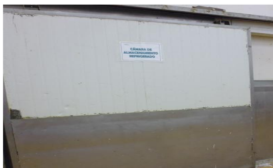
FIGURA N° 31: CÁMARA DE ALMACENAMIENTO.
