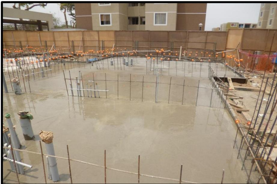
**FOTO N° 12.-** Vista panorámica de la armadura de los muros y del encofrado en proceso. Obsérvese también el acabado de los muros después del vaciado del concreto.
