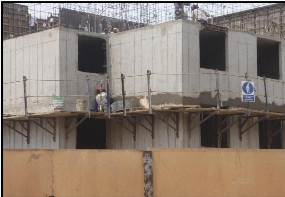
**FOTO N° 14.-** Vista panorámica de los muros interiores listos para el solaqueo interior.
