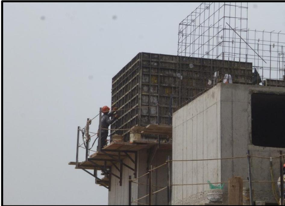
**FOTO N° 13.-** Vista panorámica del solaqueo exterior que se ejecuta paralelamente al armado y encofrado de los muros del piso superior.
