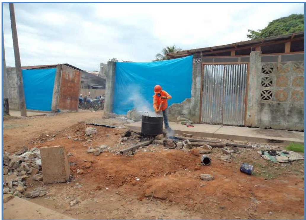
VISTA DEL PREPARADO DE ASFALTO RC 250 ARENA PARA EL SELLADO EN VEREDAS
