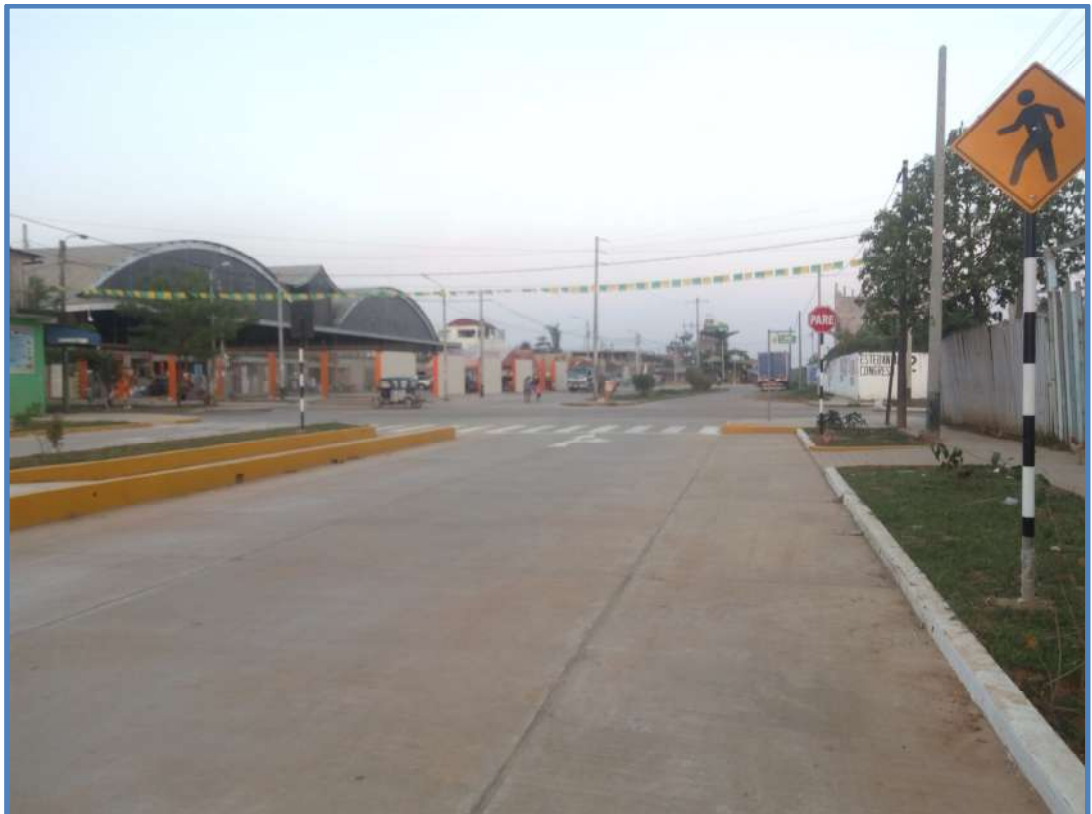
VISTA DE VIA CONCLUIDA
