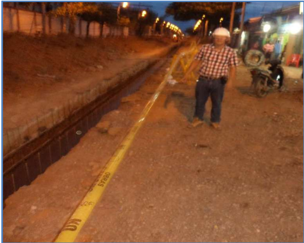
VISTA DE DELIMITACION DE ZANJAS EN CANALES
