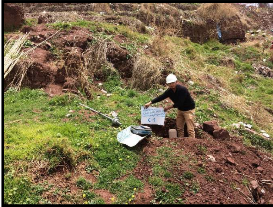
Fotografía N° 1: Excavación de la calicata C-1.
