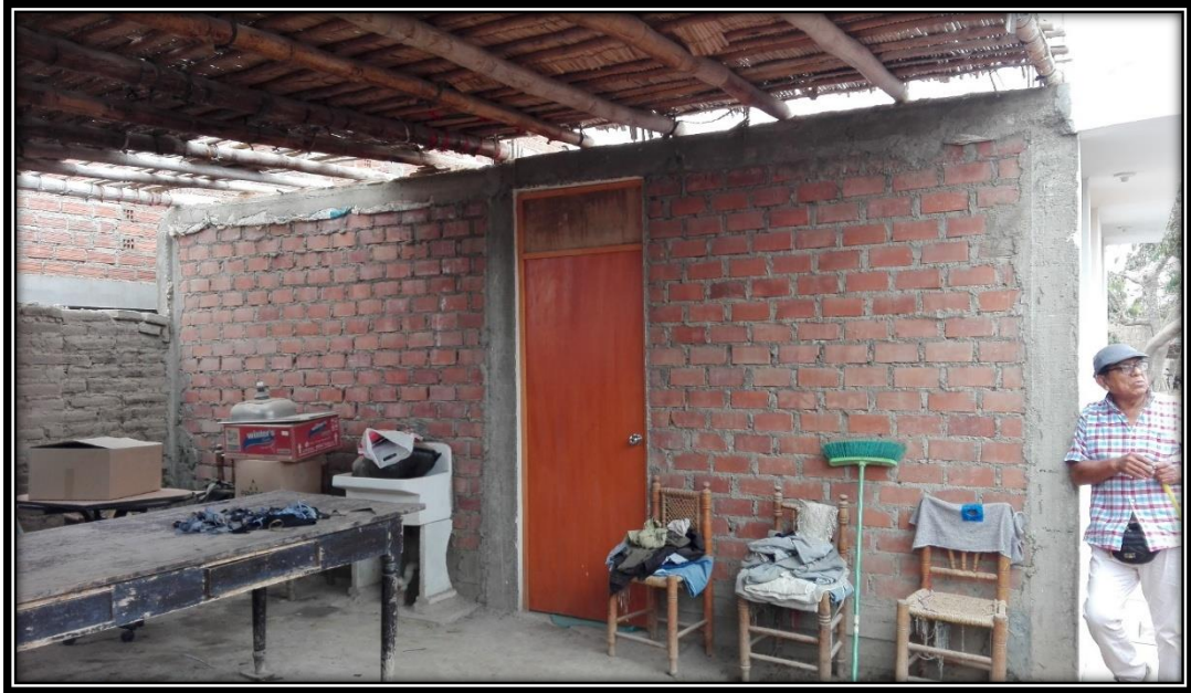
Figura 05: vivienda perteneciente a Gaby Lévano Edificación de mampostería con columnas
