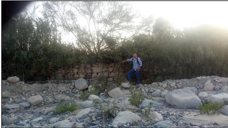
Figura 11: Se visualiza gaviones deteriorados en el cauce del río en estudio.
