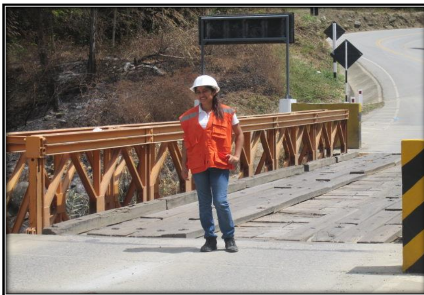
Imagen N° 03: Tramo del Puente la Afiladera
