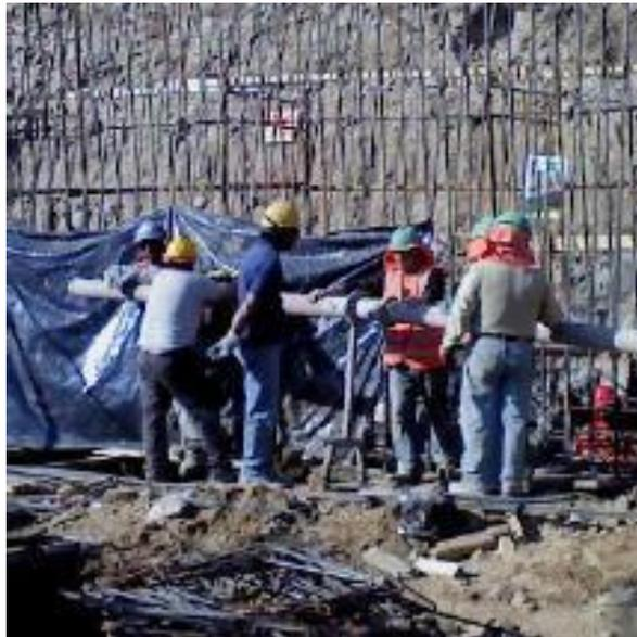
*Figura 2.7: Pérdida: Espera para vaciar por falta del mixer.*
