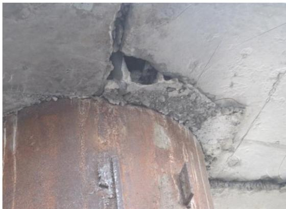
*Figura 2.6: Formación de "cangrejas" por mal vibrado de la mezcla de concreto*
