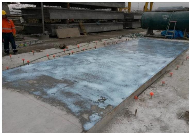
*Figura 3.15: Aplicación de desmoldante*
