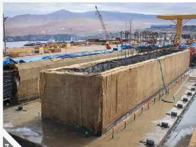
*Figura 3.22: Curado de prefabricado*
