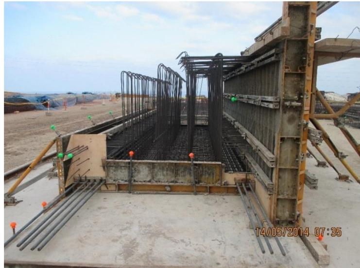
*Figura 3.14: Armado de mallas de acero*
