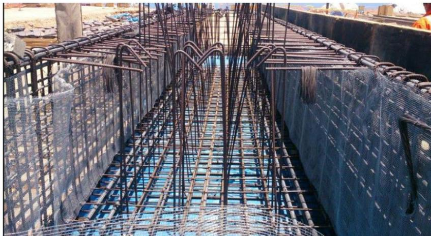
Figura 3.19: Encofrado interior con malla gallinero
