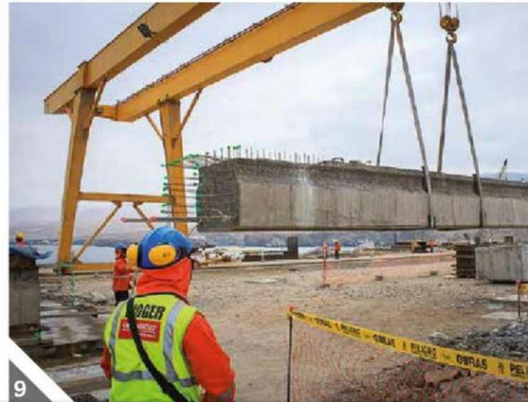
*Figura 3.26: Izaje de prefabricado*
