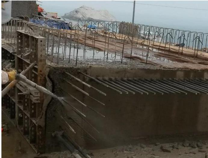
*Figura 3.21: Lavado de superficie de concreto*
