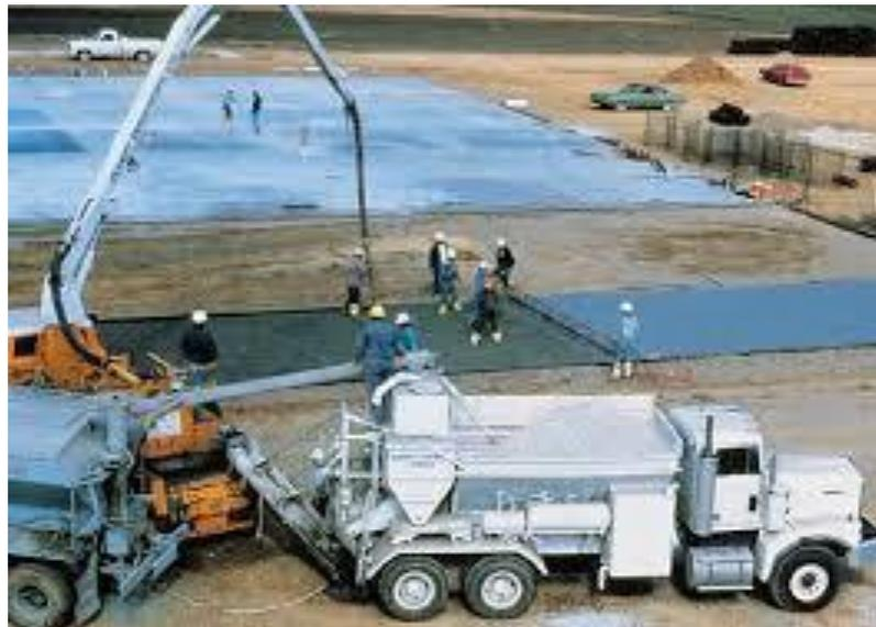
*Figura 2.1: Descarga del camión mezclador hacia la estructura.*
