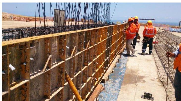
*Figura 3.17: Encofrado prefabricado*
