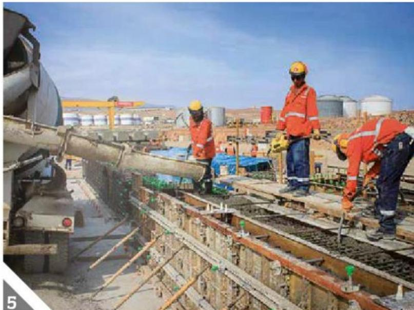
*Figura 3.20: Colocación de concreto*
