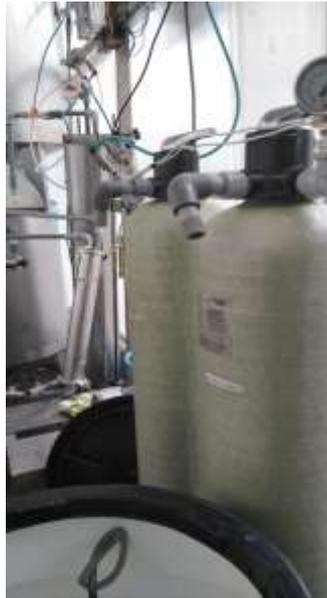
**FIGURA N° 03: FILTROS QUE CONTIENEN CARBON ACTIVADO**
