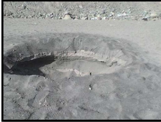
Foto 5: Calicata en AA.HH. Pucchún, para la planta de tratamiento de agua potable.
