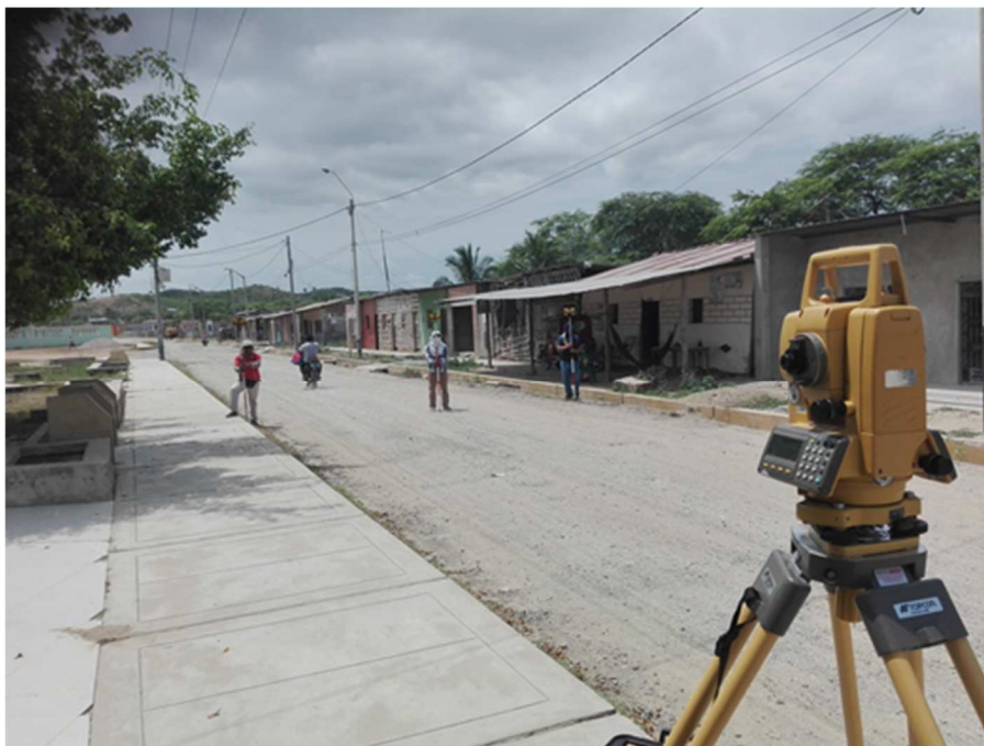
Figura N° 4.4 (Levantamiento topográfico con estación total)
