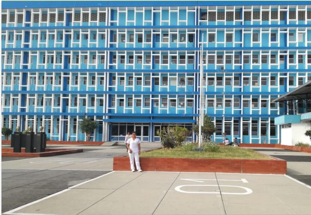
Foto N° 01: Vista frontal del Hospital III EsSalud José Cayetano Heredia de Piura
