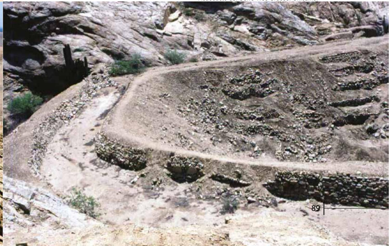
Sabido es que cuando un canal con flujo subcrítico ( $F < 1$ ) entra en un canal más ancho, se expande y desacelera. Un canal supercrítico ( $F > 1$ ), en cambio, acelera su velocidad cuando el fondo del canal aumenta bruscamente en pendiente negativa, y el tirante o profundidad disminuye. En otras palabras, esta técnica de acelerar o frenar el flujo, que se explica con la fórmula de Froude, fue conocida y muy bien empleada por los constructores andinos.
