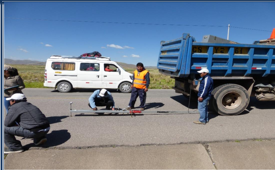
FOTOGRAFIA N° 16 TRAMO JULIACA LAMPA EVALUANDO LA PARTE ESTRUCTURAL EN DONDE SE VE UN CAMION VOLQUETE CARGADO DE 8.2 TN Y LA VIGA BENKELMAN ENTRE LOS NEUMATICOS EN CARRIL DERECHO.
