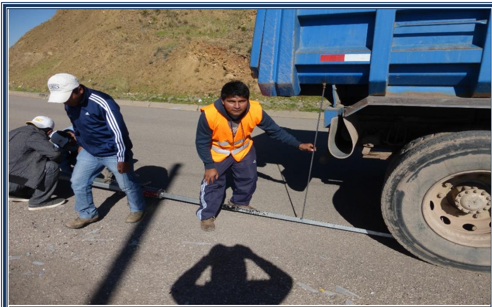
FOTOGRAFIA N° 15 TRAMO JULIACA LAMPA EVALUANDO LA PARTE ESTRUCTURAL EN DONDE SE VE UN CAMION VOLQUETE CARGADO DE 8.2 TN Y LA VIGA BENKELMAN ENTRE LOS NEUMATICOS EN CARRIL DERECHO.
