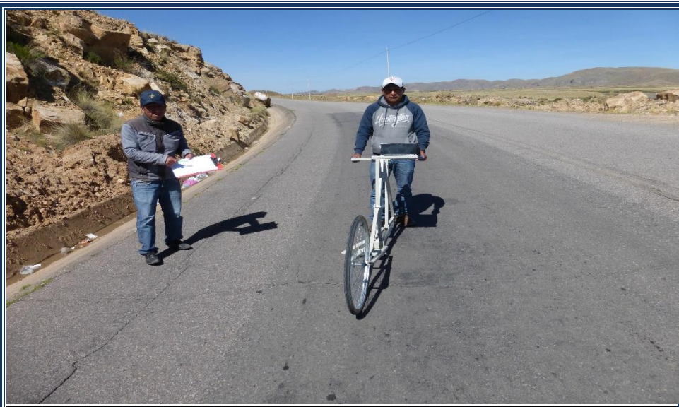
FOTOGRAFIA N° 04 TRAMO JULIACA LAMPA EVALUANDO PA LA PARTE FUNCIONAL CON EL INSTRUMENTO RUGOSIMETRO MERLIN Y LA LECTURA
