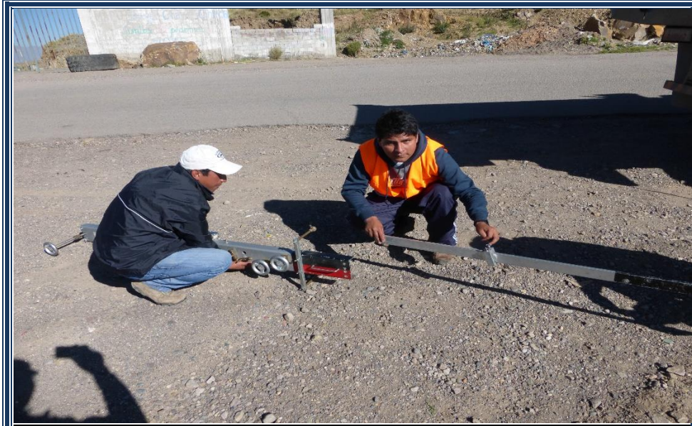
FOTOGRAFIA N° 13 TRAMO JULIACA LAMPA EVALUANDO LA PARTE ESTRUCTURAL EN DONDE SE REALIZA EL ARMADO DE VIGA BENKELMAN.
