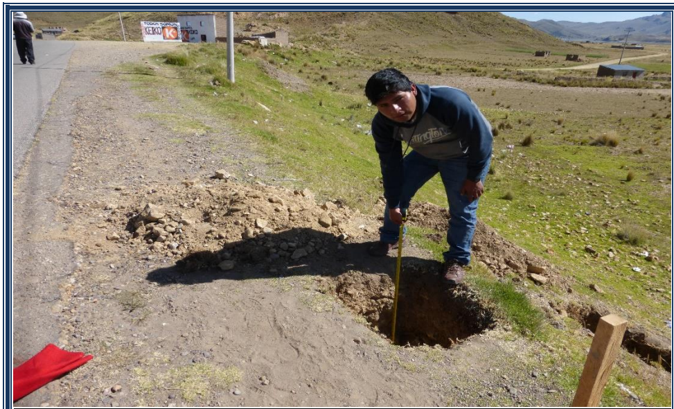
FOTOGRAFIA N° 12 TRAMO JULIACA LAMPA EVALUANDO PA LA PARTE FUNCIONAL EN DONDE SE REALIZA LA CALICATA PARA VER LA SUB BASE , BASE EN EL PAVIMENTO FLEXIBLE
