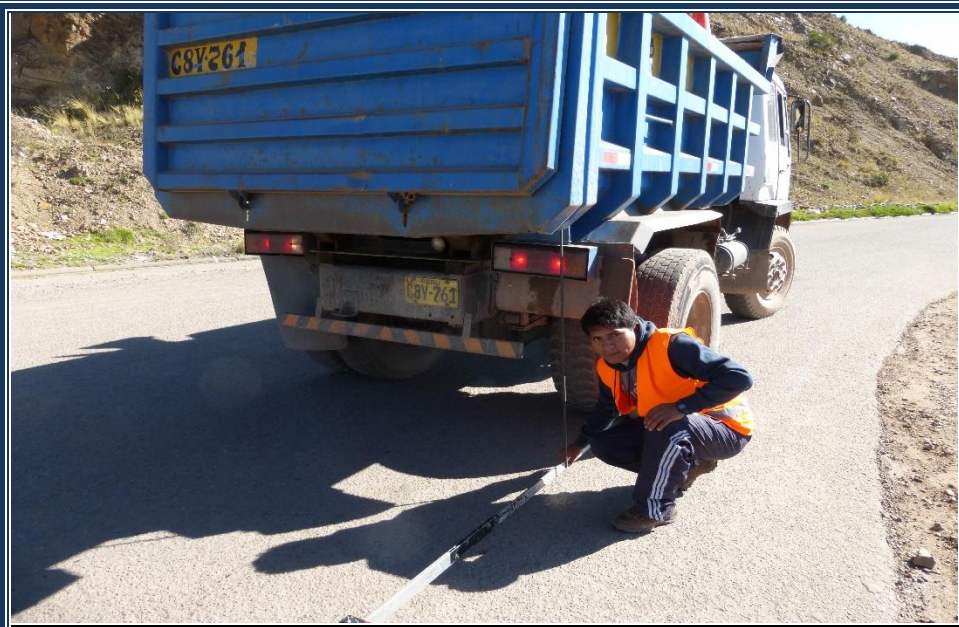
FOTOGRAFIA N° 14 TRAMO JULIACA LAMPA EVALUANDO LA PARTE ESTRUCTURAL EN DONDE SE VE UN CAMION VOLQUETE CARGADO DE 8.2 TN Y LA VIGA BENKELMAN ENTRE LOS NEUMATICOS.
