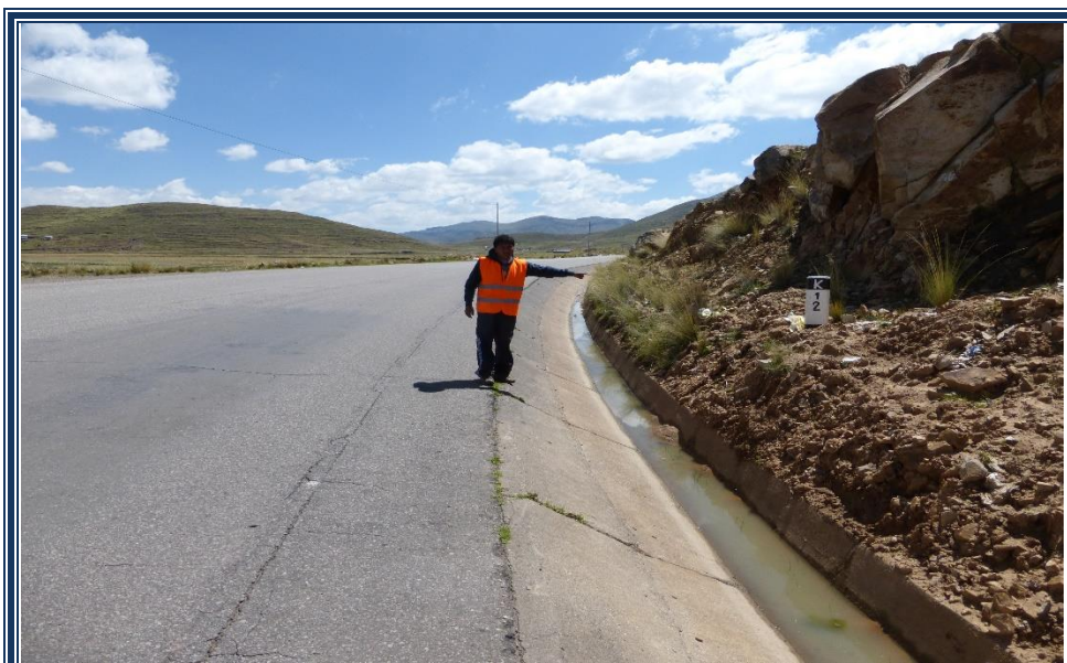
FOTOGRAFIA N° 19 TRAMO JULIACA LAMPA EVALUANDO LA PARTE ESTRUCTURAL EN DONDE SE VE KM 12+000 DEL CARRIL DERECHO.
