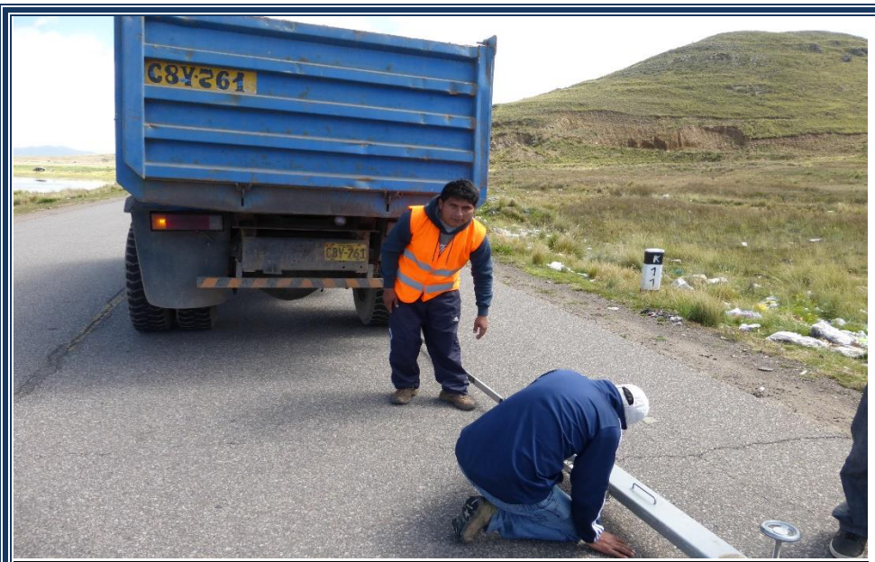
FOTOGRAFIA N° 18 TRAMO JULIACA LAMPA EVALUANDO LA PARTE ESTRUCTURAL EN DONDE SE VE ENTRE LOS NEUMATICOS DE VIGA BENKELMAN EN CARRIL DERECHO.
