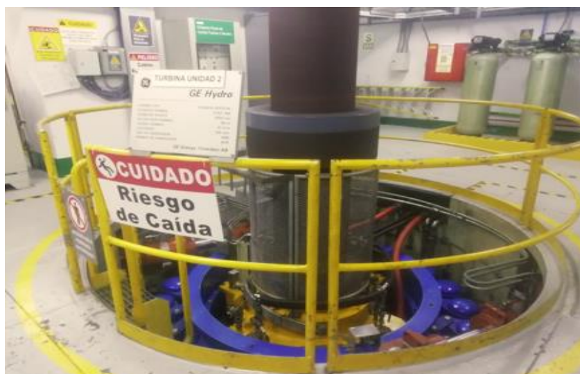
Tapa Turbina, zona de Tubos Compensación
