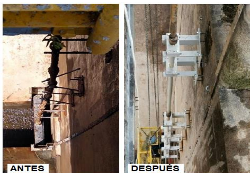
Gráfico 40 Instalación de Soportes y Guías
