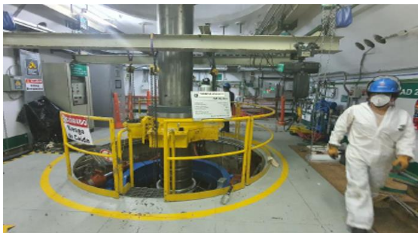
Desmontaje de Sistema Óleo Hidráulico y Acceso al Sello Turbina
