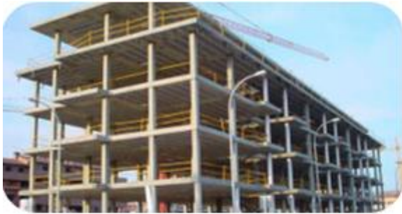
Construcción de edificios
