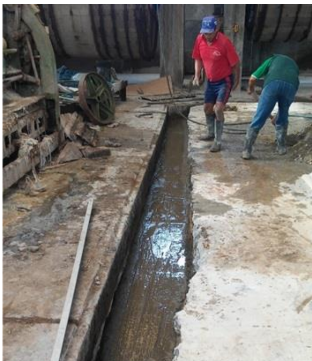
Ensanchamiento de Canaletas de Vertidos
