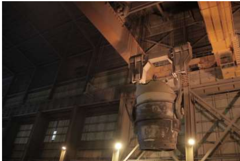
Grúa Puente de Acería
