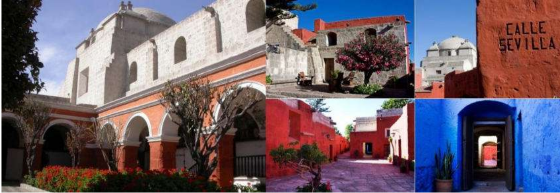
Imagen 01: Convento de Santa Catalina, muestra maestra de la arquitectura de Sillar en Arequipa.
