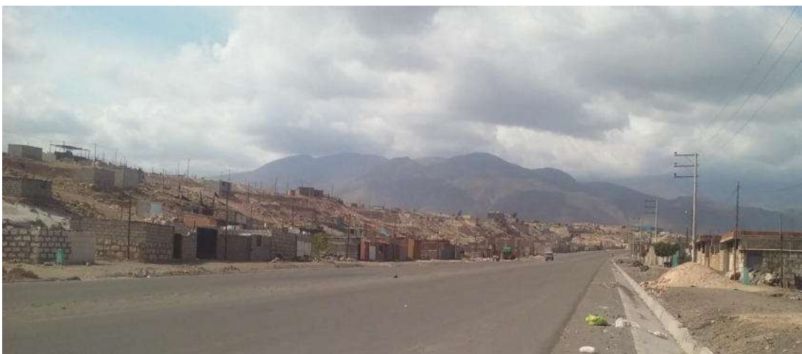
ENTORNO URBANO AUTOPISTA AREQUIPA – LA JOYA
