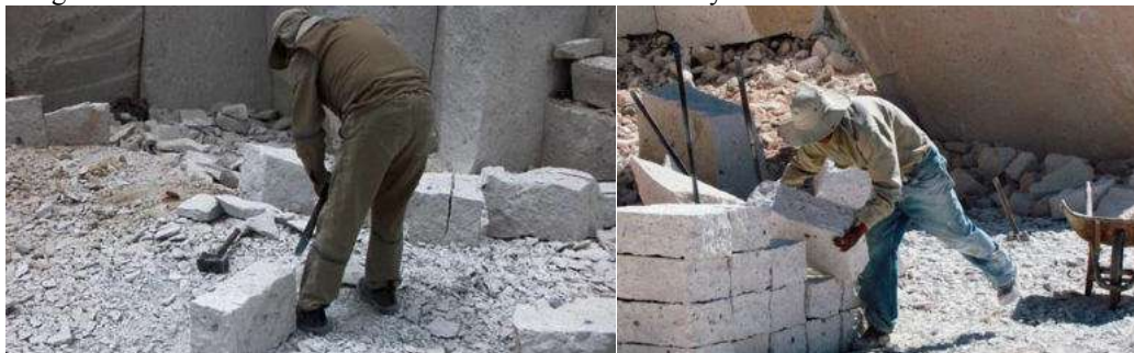
Imagen 16: Cortadores de Sillar en las Canteras de Añashuayco.
