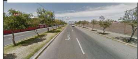
2: COLECTORA (AV. AEROPUERTO)
