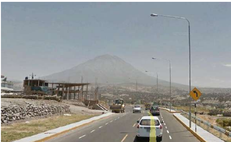
Imagen 52. Sistema de alcantarillado y desagüe en vía la ronda - Carmen Alto. Fuente: Google Earth
