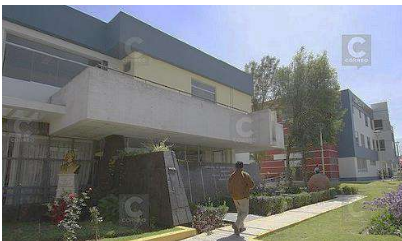
Imagen 9. Fachada interior de pabellón antiguo. Fuente: Diario Correo – Edición Arequipa
