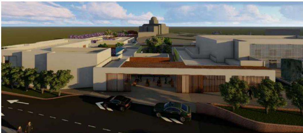
Figura 109. Vista Sector 2 – Acceso principal unidad de atención y consultas. Fuente: Elaboración propia.
