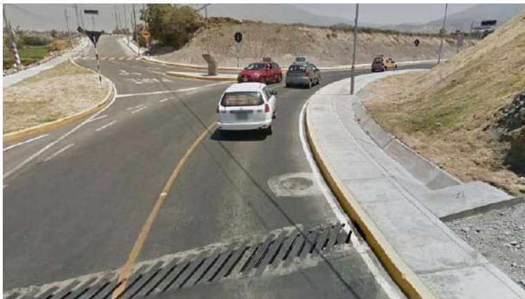
Imagen 51. Sistema de alcantarillado y desagüe en vías - Carmen Alto. Fuente: Google Earth
