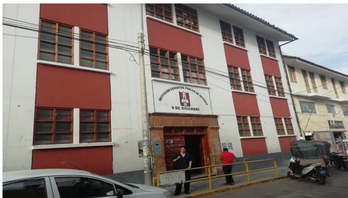
Figura N° 2. Ingreso principal de una de los centros educativos de nivel primario de Huamanga, Ayacucho - 2019; en el cual se ejecutó el estudio
