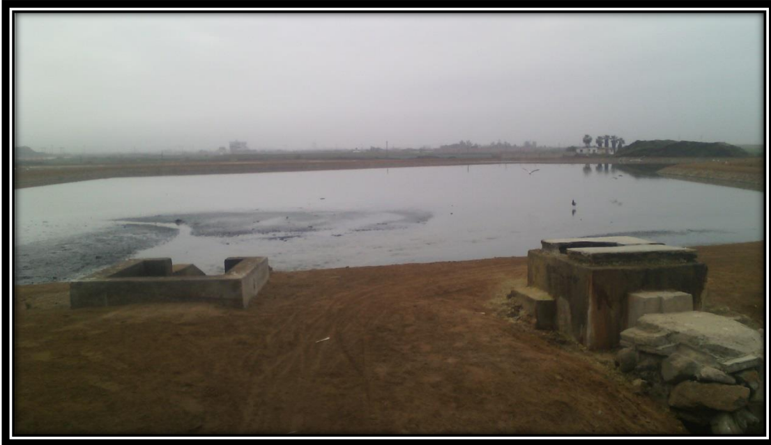
Foto N° 01: “LAGUNA DE ESTABILIZACIÓN TORRES DE SAN BORJA - MOCHE”
