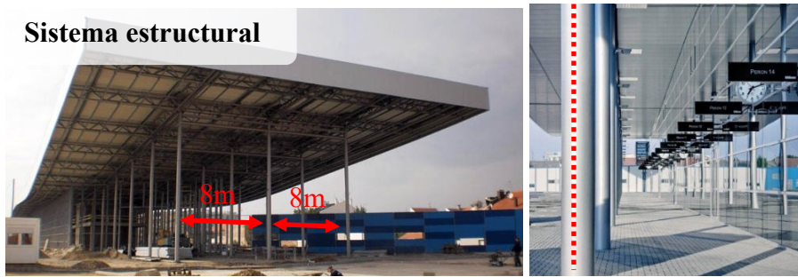
Imagen 14. Vista del sistema estructural del terminal de buses Osijek
