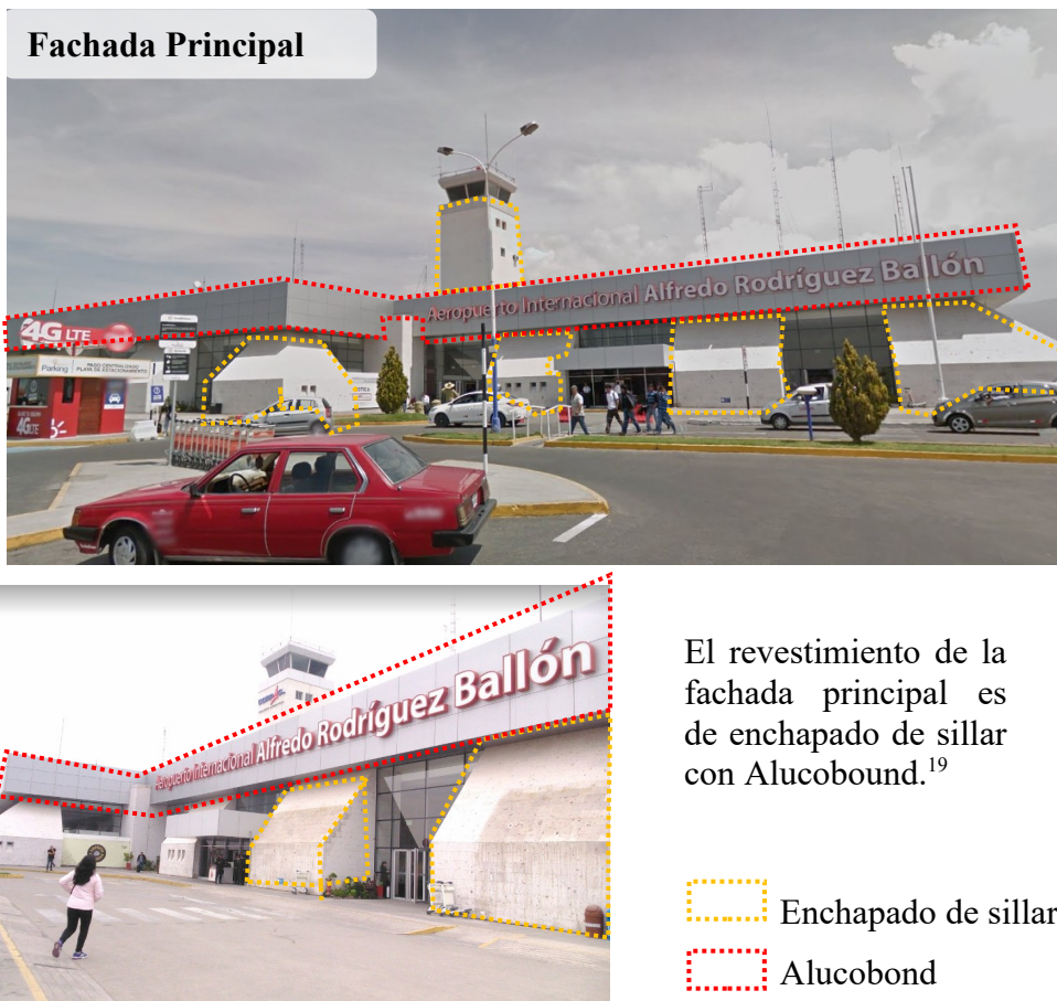
Imagen 9. Tipo de material en la fachada principal del aeropuerto
