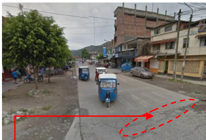
Ilustración 5: Inadecuado accesibilidad vehicular por las pistas deterioradas.
