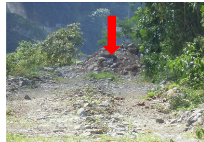
Ilustración 3: Inadecuado sendero para el uso peatonal.
