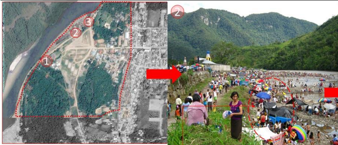
Imagen 1. Vista aérea del sector de las brisas del Huallaga Fuente: GOOGLE EARTH
