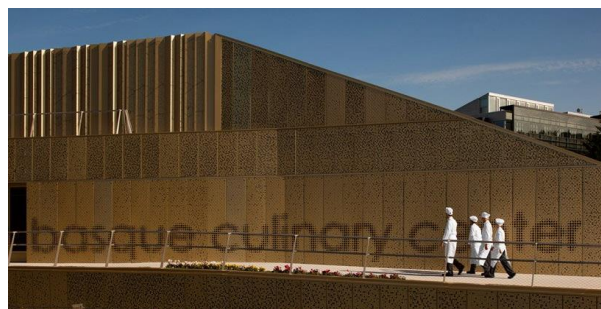
Imagen 22 Fachada con recubrimiento de aluminio anodizado (Desingboon, s.f.).
