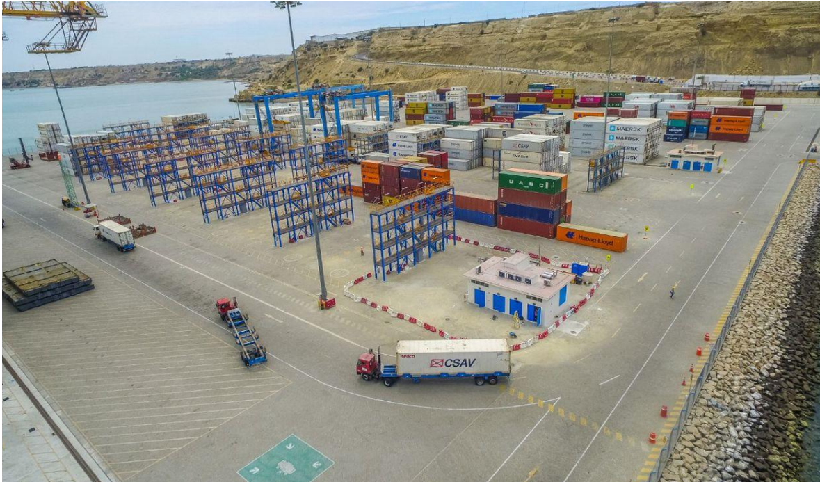
Figura 22 Muelle para Cargas y descargas
