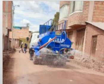
Riego para Sub base
