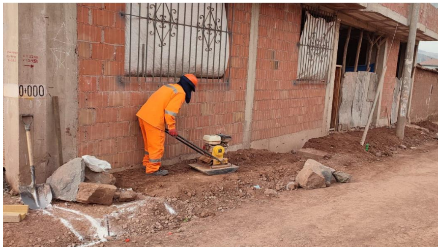
Imagen 35 Perfilado y compactado de veredas
