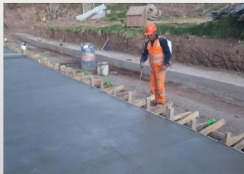
Curado de concreto
