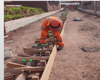
Encofrado para el pavimento
