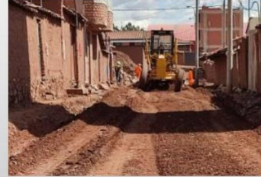
Extendido de Sub base
