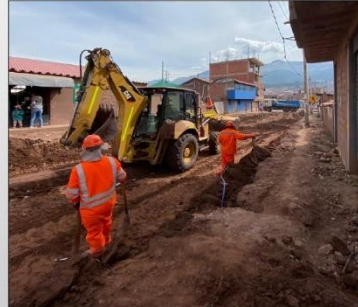
Corte de Terreno con maquinaria profundidad 1.2m
