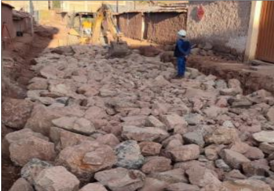
Imagen 15 Mejoramiento de la sub Rasante con piedra bruta de 15”
