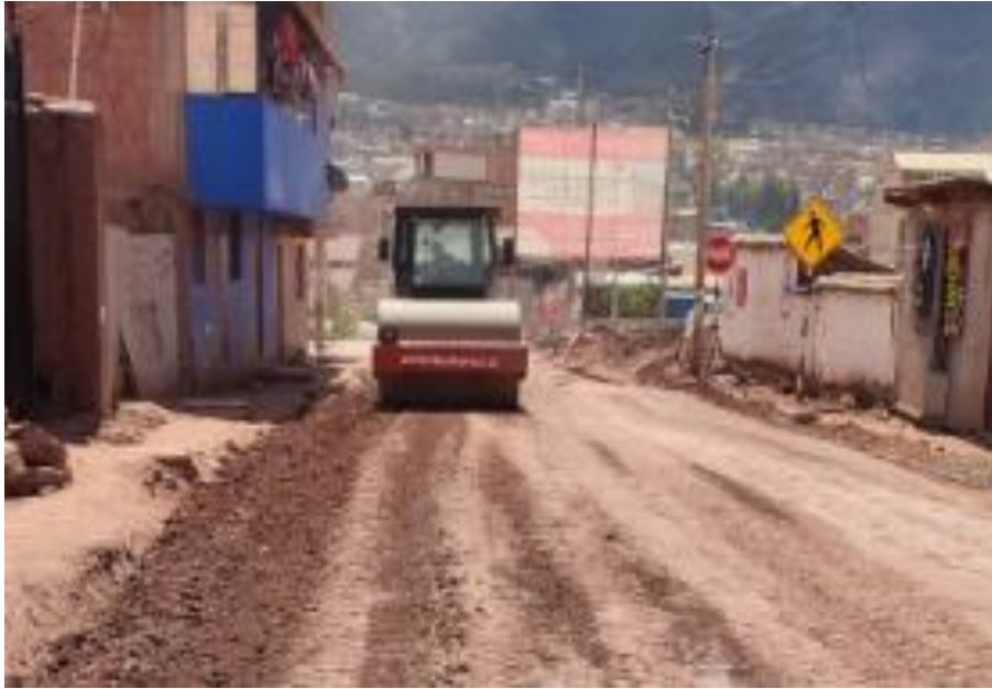
Imagen 19 Compactado de Sub base
