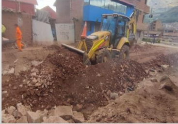
Sellado de enrocado con Over.
