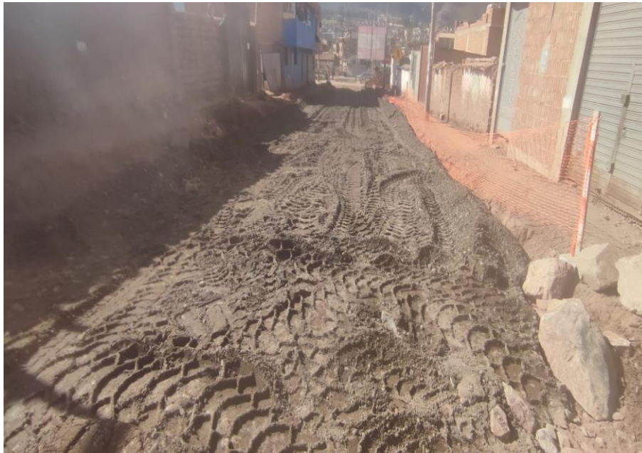
Imagen 17 Capa anticontaminante E=10cm
