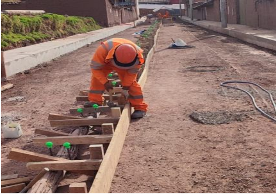
Imagen 21 Encofrado par el pavimento
