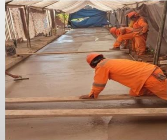
Acabados de losa de concreto
