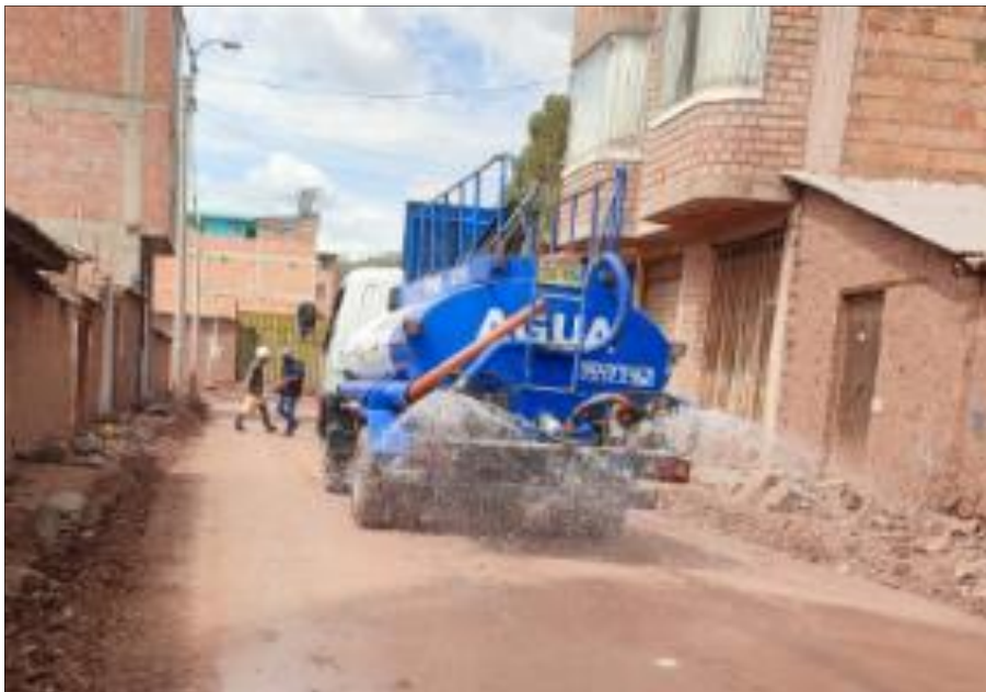
Imagen 20 Riego para Sub base
