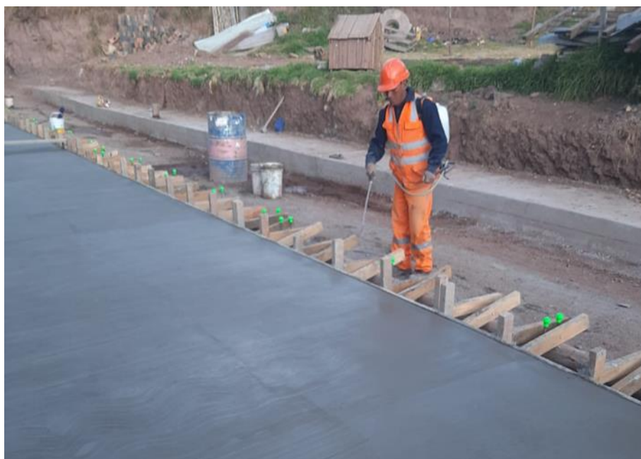
Imagen 25 Curado de concreto
