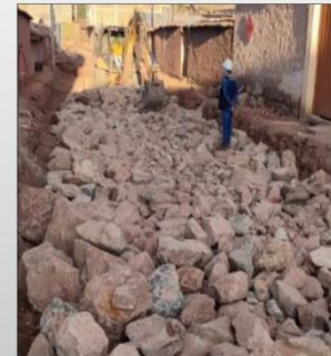
Mejoramiento de la sub Rasante con piedra bruta de 15"
