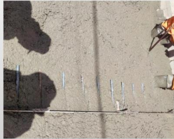
Colocado de acero para junta de contracción de ¼"
