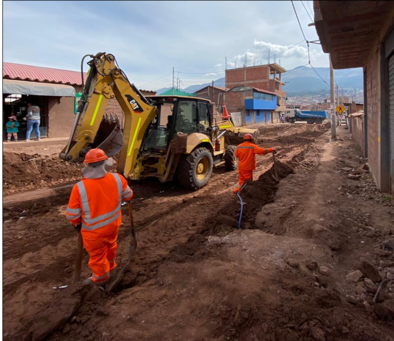
Imagen 14 Corte de Terreno con maquinaria profundidad 1.2m.
