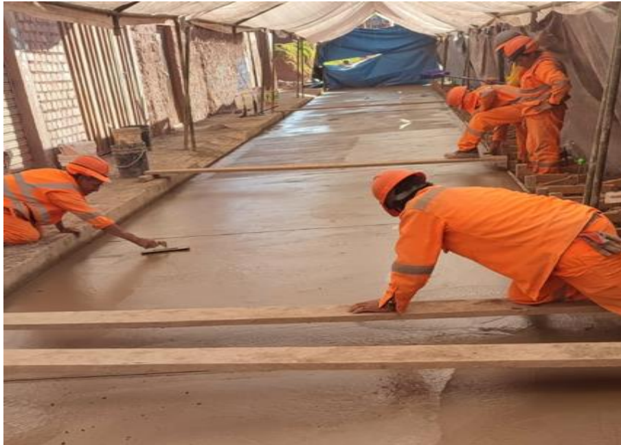
Imagen 24 Acabados de Losa de concreto
