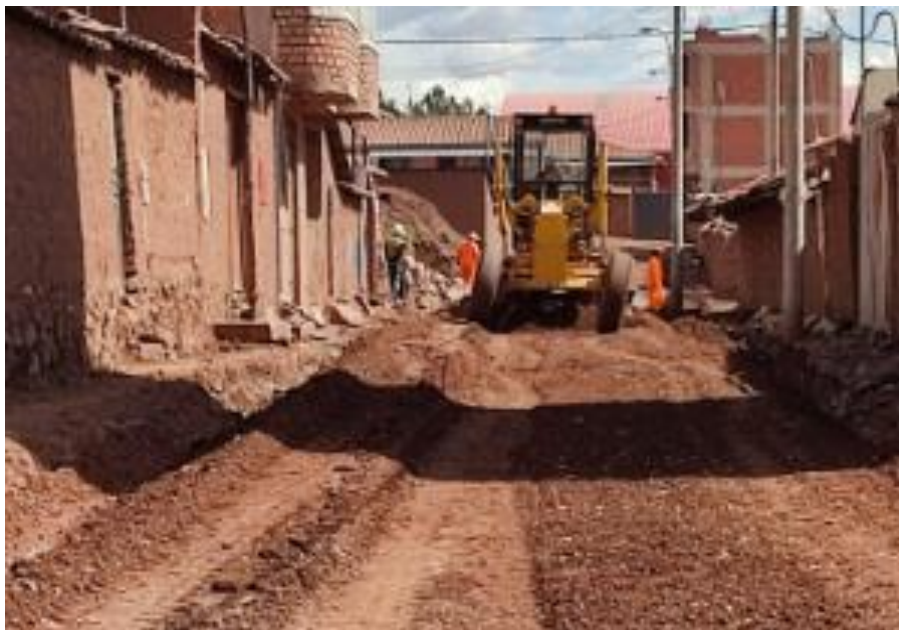
Imagen 18 Extendido de Sub base
