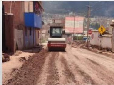
Compactado de Sub base
