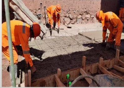
Colocado de acero de temperatura de ¼" en pavimento
