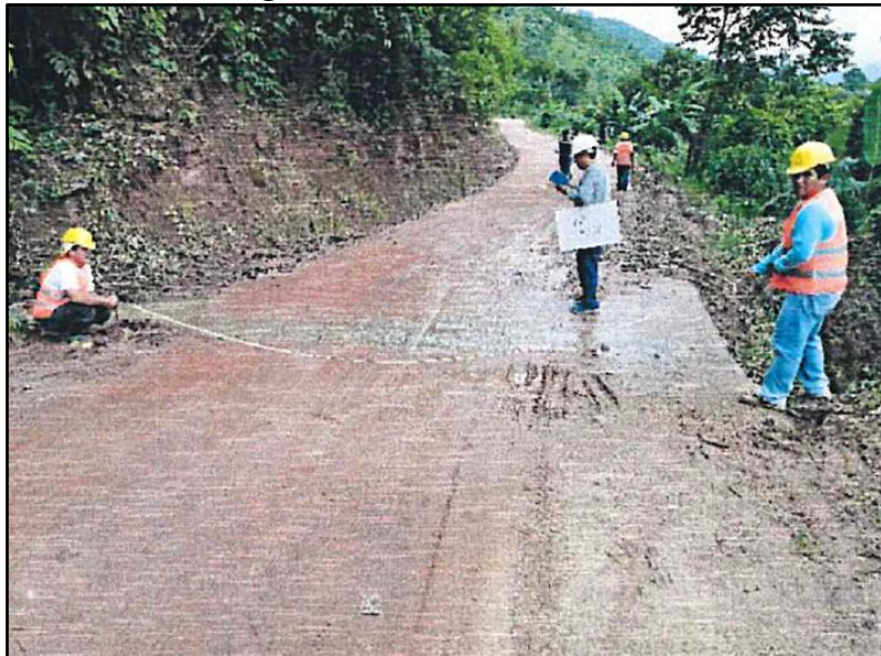
Fotografía 8. Badén de concreto
