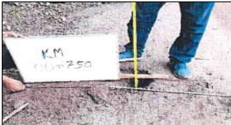
Fotografía 4: Vista del espesor de 7.00 cm del afirmado existente en el Km 00+750
