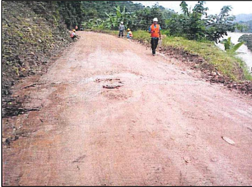
Fotografía 7. Tajea Colapsada
