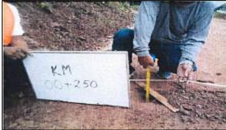
Fotografía 3: Vista del espesor de 10.00 cm del afirmado existente en el Km 00+250
