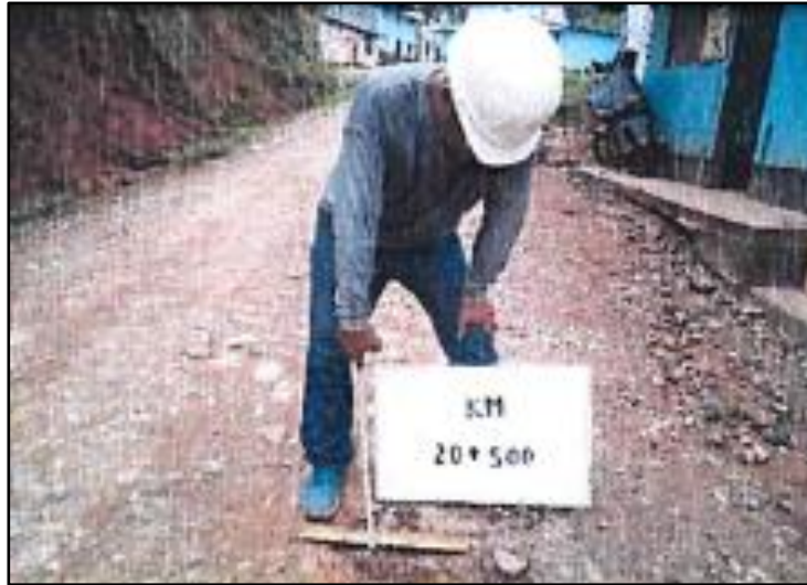
Fotografía 5: Vista del espesor de 2.00 cm del afirmado existente en el Km 20+500
