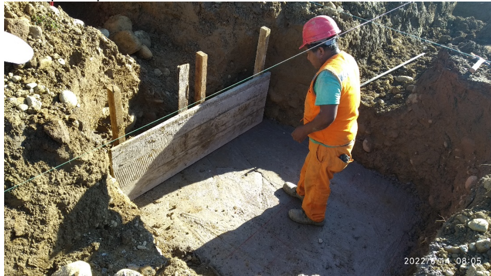
Foto 5: Solado para zapatas.
