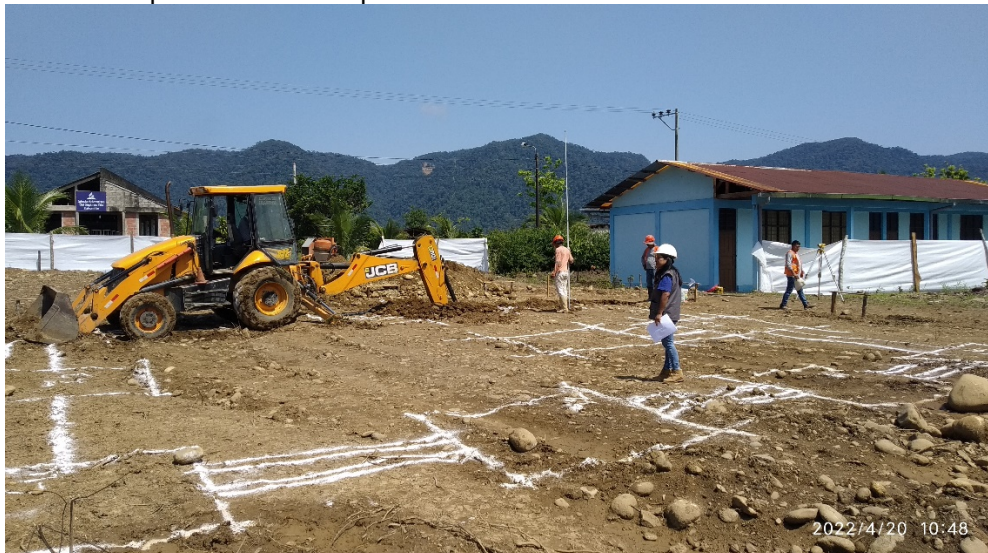
Foto 3: Excavación para cimientos-zapatatas.
