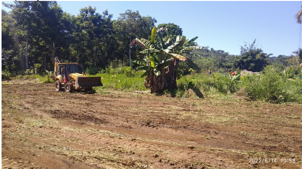
Foto 1: Limpieza y desbroce de maleza, en el área a construir.
