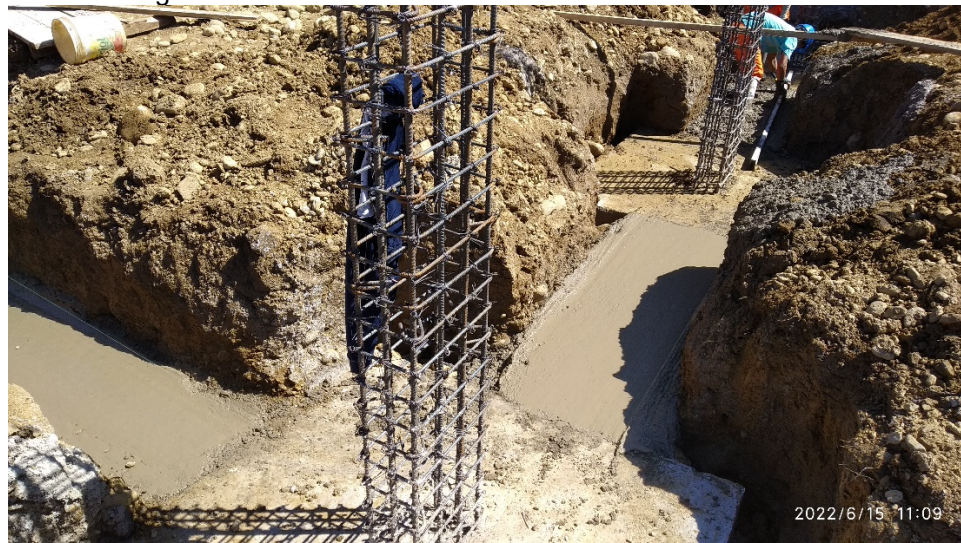
Foto 6: Solado en vigas de conexión.
