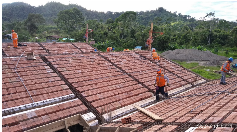
Foto 12: Colocado de ladrillo en techo.
