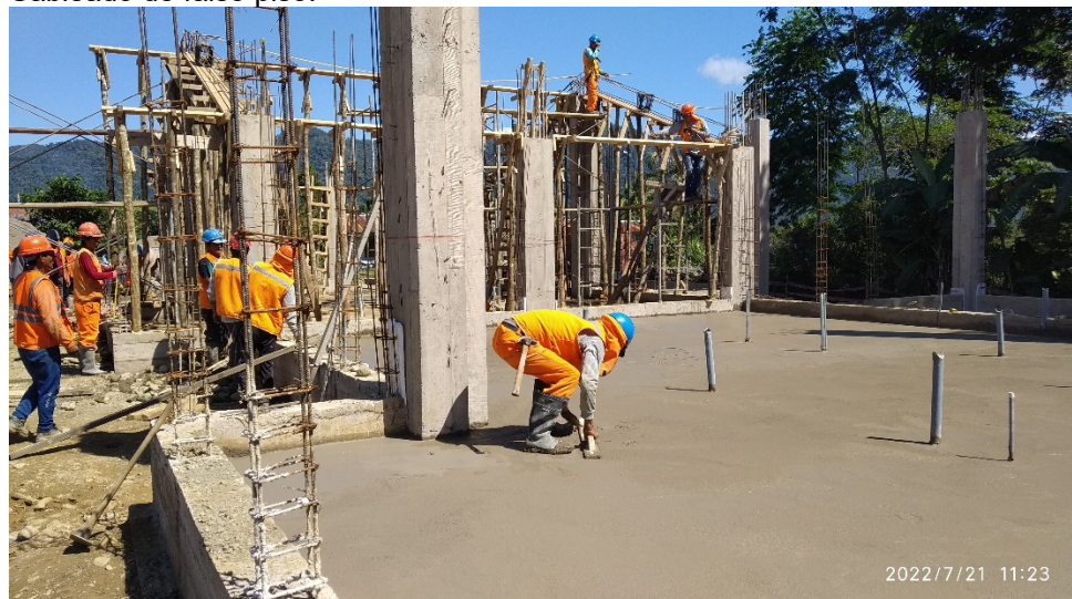
Foto 8: Sableado de falso piso.
