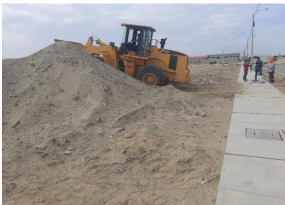
Foto N° 10: Extracción, carguío y transporte de material de préstamo (Parque Piura Futura).
