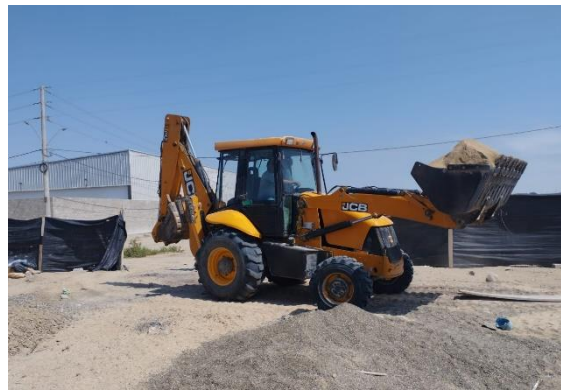
Foto N° 15: Acarreo y eliminación de material Excedente (proveniente de cemento corrido).
