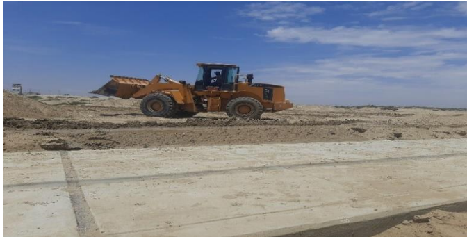
Fotografía 2: Nivelación de Terreno (Retroexcavadora)
