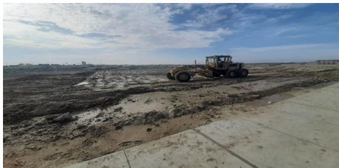
Fotografía 3: Nivelación de Terreno (Motoniveladora)
