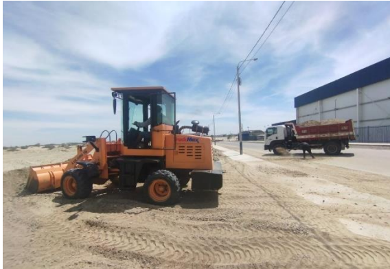
Foto N° 12: Acarreo y eliminación de material excedente (proveniente de material préstamo).
