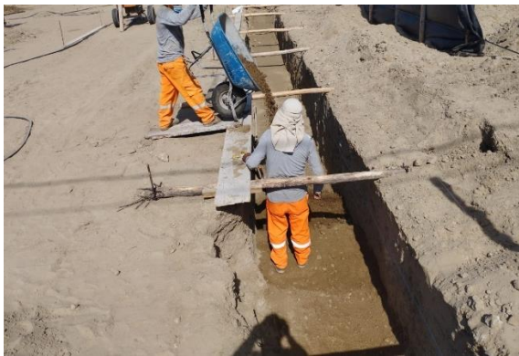
Foto N° 14: Relleno con material de préstamo Afirmado (e = 20 cm).
