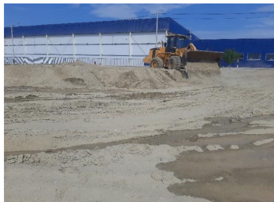
Foto N° 11: Relleno con material de préstamo (Parque Piura Futura).
