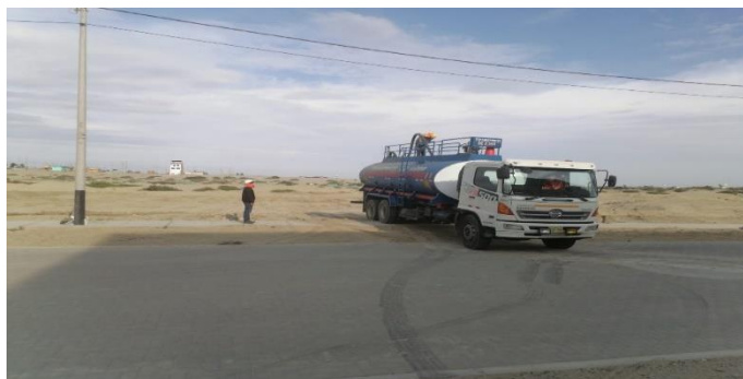
Fotografía 4: Riego con Camión Cisterna
