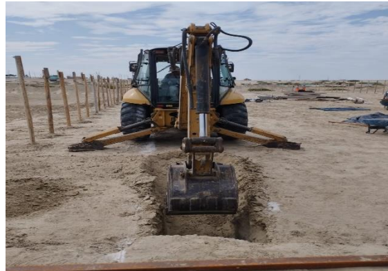
Foto N° 13: Excavación de terreno para muros de block.
