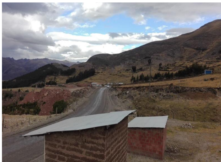
IMAGEN 13 PASO DE TUBERIA DE DISTRIBUCION EN LA CARRETERA VIA NACIONAL
