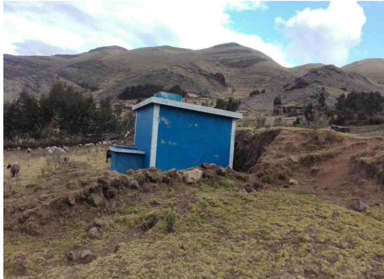
IMAGEN 11 VISTA PANORAMICA RESERVORIO EXISTENTE
