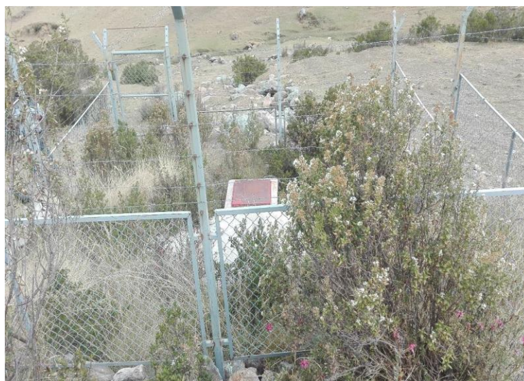
IMAGEN 14 VISTA DE LA CAPTACION MAYCHAYHUAYCCO EXISTENTE
